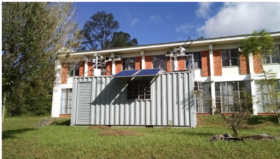
Figura 8 - Local de instalação da estação solarimétrica
