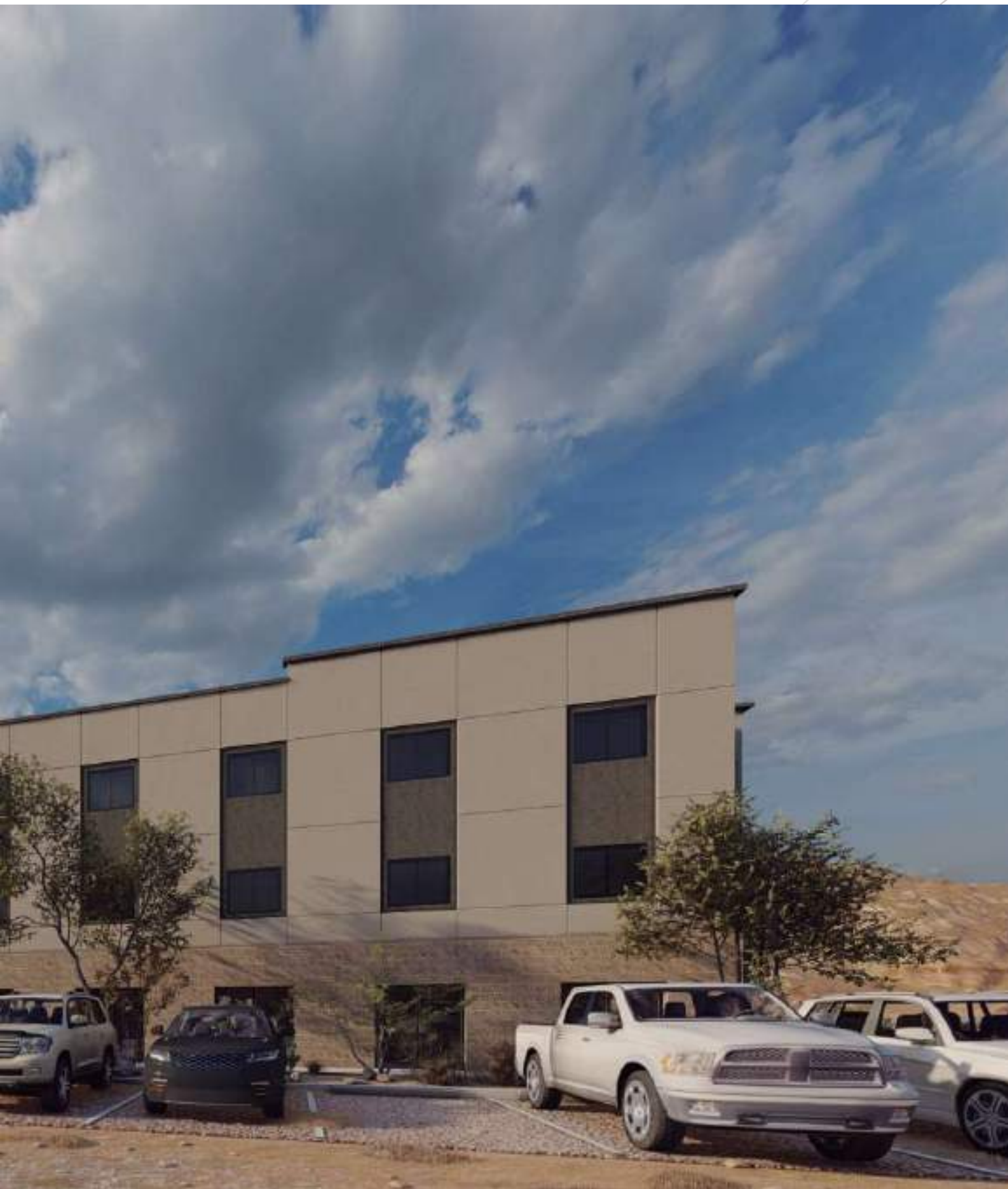
Centro de descanso y estadía para el personal técnico y administrativo de la mina La Herradura, con habitaciones, lavandería, gimnasio, comedor-cocina, recepción, área de juegos y cafetería.
