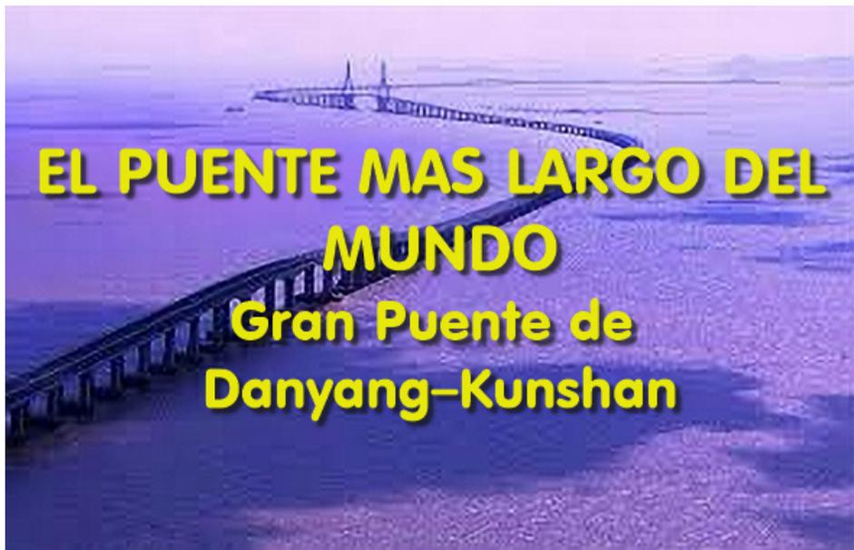
**Materiales utilizados:** Se utilizaron 450,000 toneladas de acero y 2.3 millones de metros cúbicos de cemento en su construcción.
