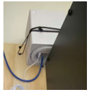
Verizon internet 5G Gateway box, on back demarc of AV room
