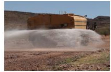
3. Wet To Specified Moisture Content
