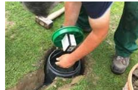
Coloque el sistema dentro del registro
