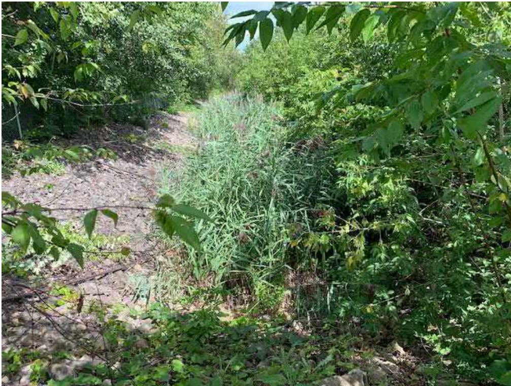
Photo 2 Bassin de sédimentation envahi de fragmite (MH3)
