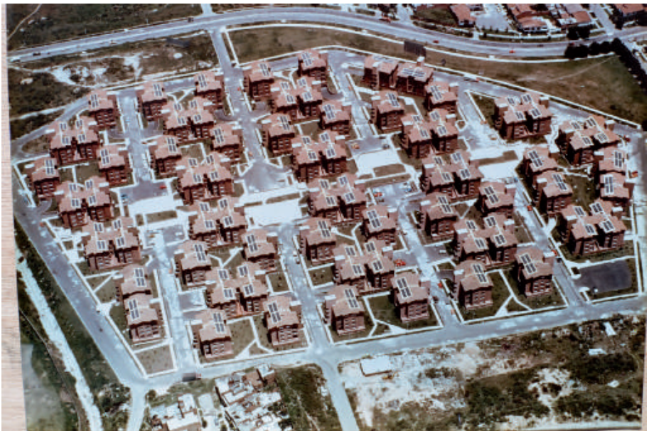
Instalación solar de GAVIOTAS para agua caliente en la urbanización Nueva Villa de Aburrá en la ciudad de Medellín
