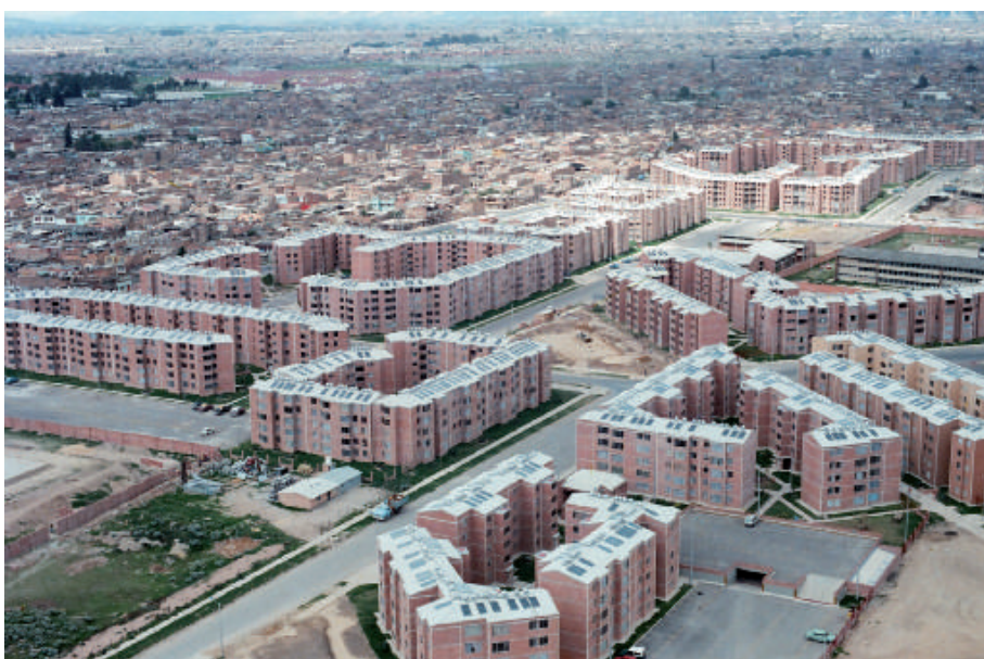
Instalación solar de GAVIOTAS para agua caliente, la más grande del mundo, en Ciudad Tunal de Bogotá
