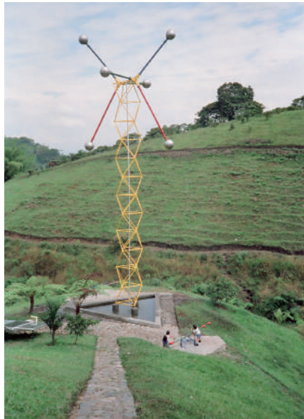
Módulo hidráulico interactivo en un parque de Vivaciencia construido por GAVIOTAS
