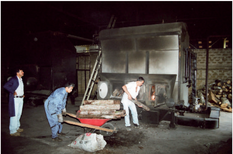
Calderas de GAVIOTAS alimentadas por troncos de madera provenientes de la poda y entresaca del bosque de pino tropical caribe
