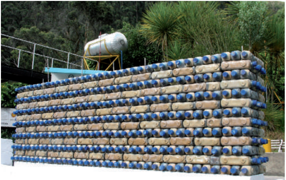
Reciclaje de botellas de agua GAVIOTAS para construcción de paredes de vivienda
