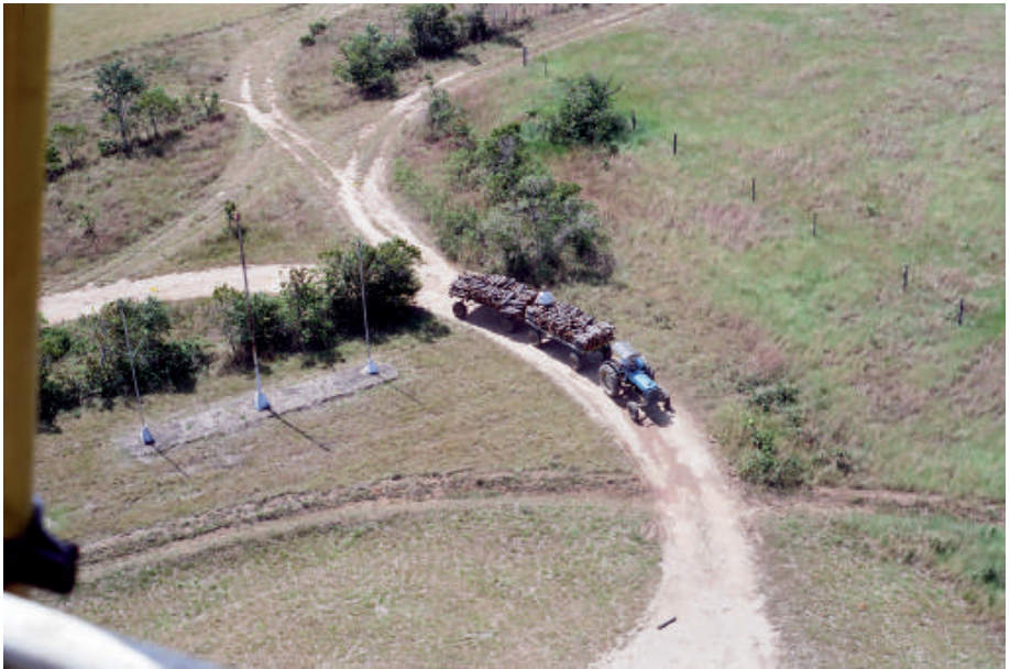
Transporte de la madera de poda y de entresaca a la planta de generación eléctrica de GAVIOTAS
