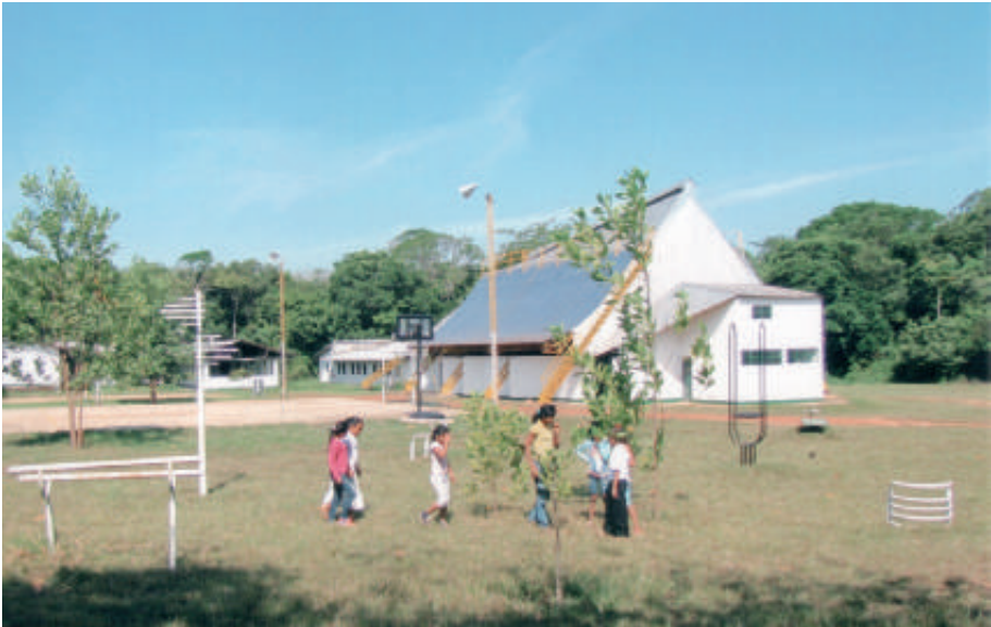
Aspecto parcial del centro las GAVIOTAS Vichada
