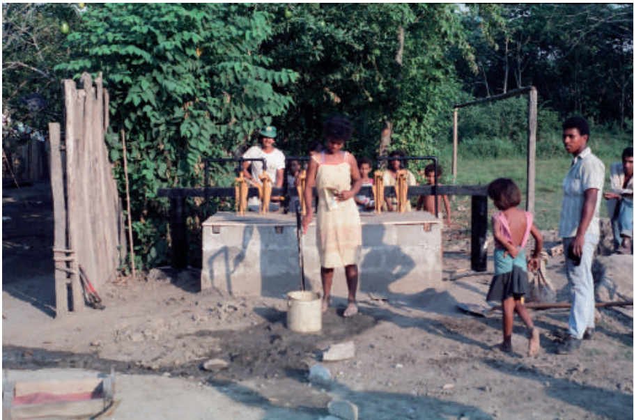
Microacueducto rural utilizando bombas de camisa GAVIOTAS
