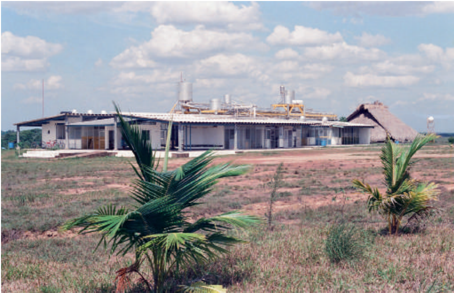
Aspecto de la envasadora de agua natural tropical proveniente del manantial subterráneo del bosque sustentable de GAVIOTAS. Antes fue el hospital autónomo
