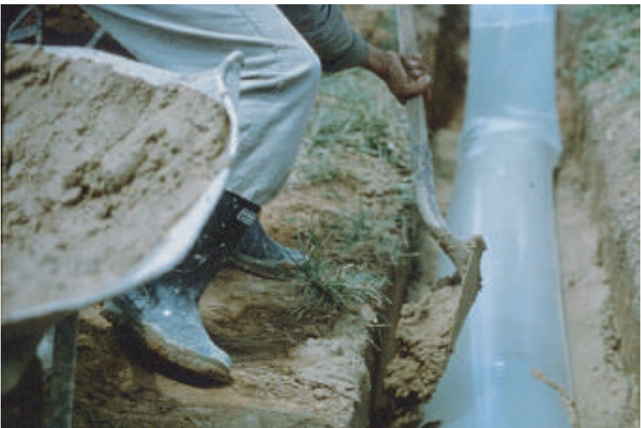
Aspecto de la fabricación del tubo tipo GAVIOTAS
