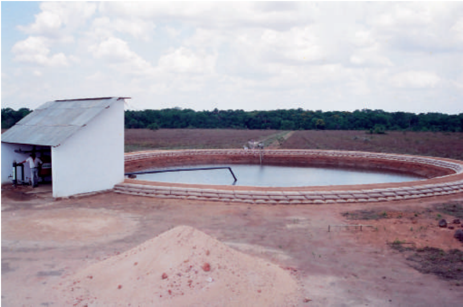
Represa de gaviones blandos de suelo-cemento del vivero de pino tropical caribe en GAVIOTAS
