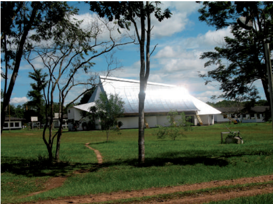
Aula múltiple bioclimática con techo reflectivo
