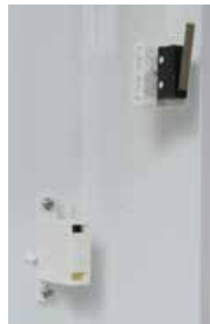
Illustration 2b: Installation des interrupteurs anti sabotage
