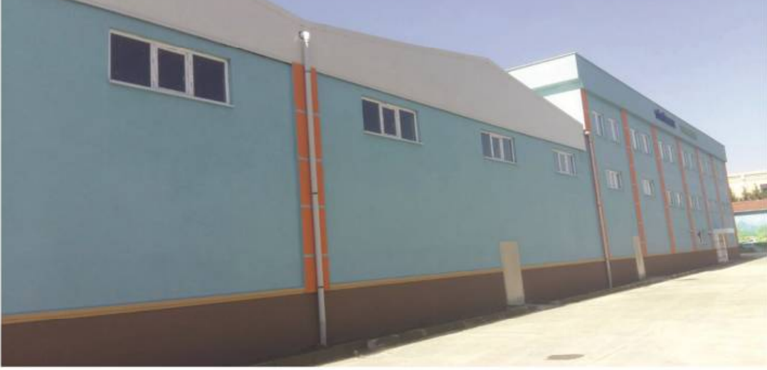
Turnalar ve Yörükler Tekstil Boya Apre San. İdari Bina Şantiyesi-ÇERKEZKÖY OSB
