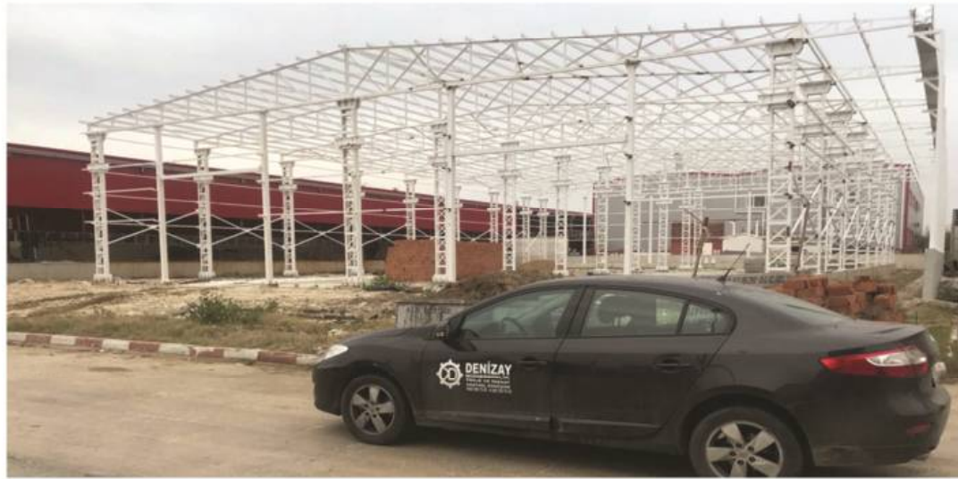
Boru Mil Sanayi Çelik Konstrüksiyon Fabrika Şantiyesi-AVRUPA SERBEST BÖLGESİ
