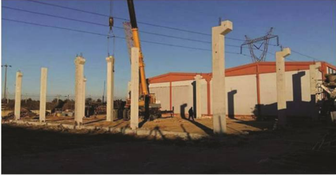
Fenplast Dede Oyuncak Depo Şantiyesi-VELİMEŞE ORGANİZE SANAYİ BÖLGESİ
