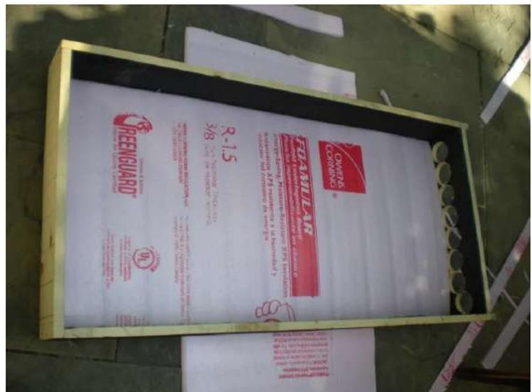
Una vez que el colector inferior esté correcto, utilícelo como plantilla para el colector superior y construya el marco necesario para sostener la lámina o ventana.
