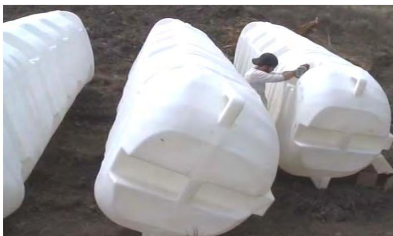
El posicionamiento de los tanques es importante ya que tienen que estar justo debajo del techo para que el agua de lluvia fluya en ellos bajo gravedad y sin embargo tienen que ser más altos que los cabezales de ducha por la misma razón (a menos que una bomba se utiliza para duchas). Un filtro simple se utiliza para quitar cualquier material soplado que encuentra su manera en la toma de agua.
