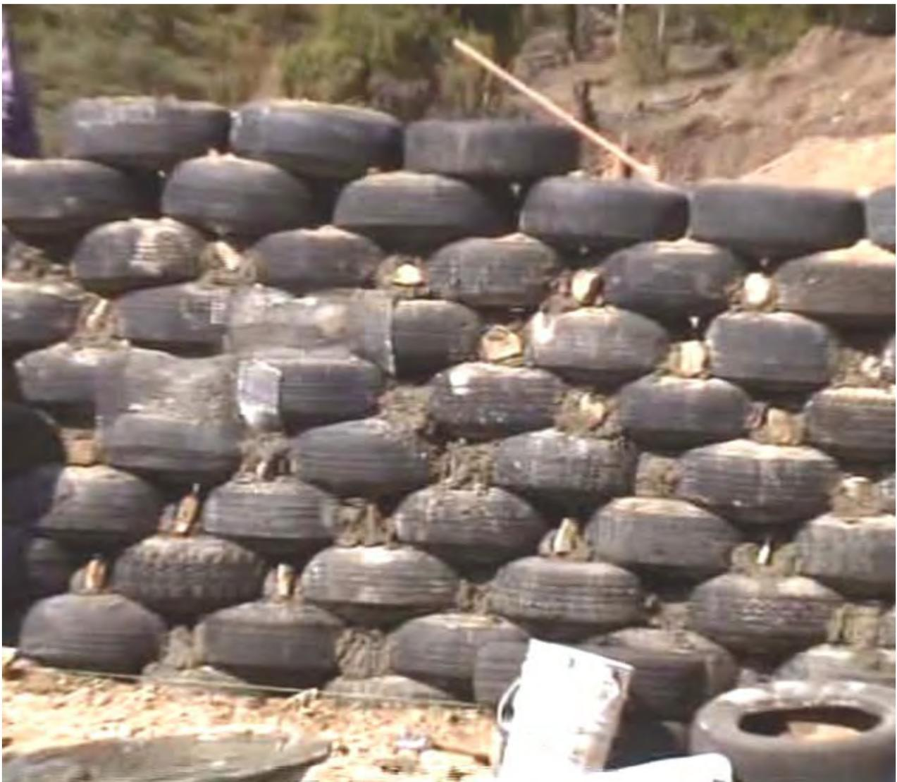
Los neumáticos se solapan en hileras sucesivas, formando una estructura estable, y luego se aplica lechada de mortero entre ellos. El exterior está encerrado en un banco de tierra y el interior se alisa.
