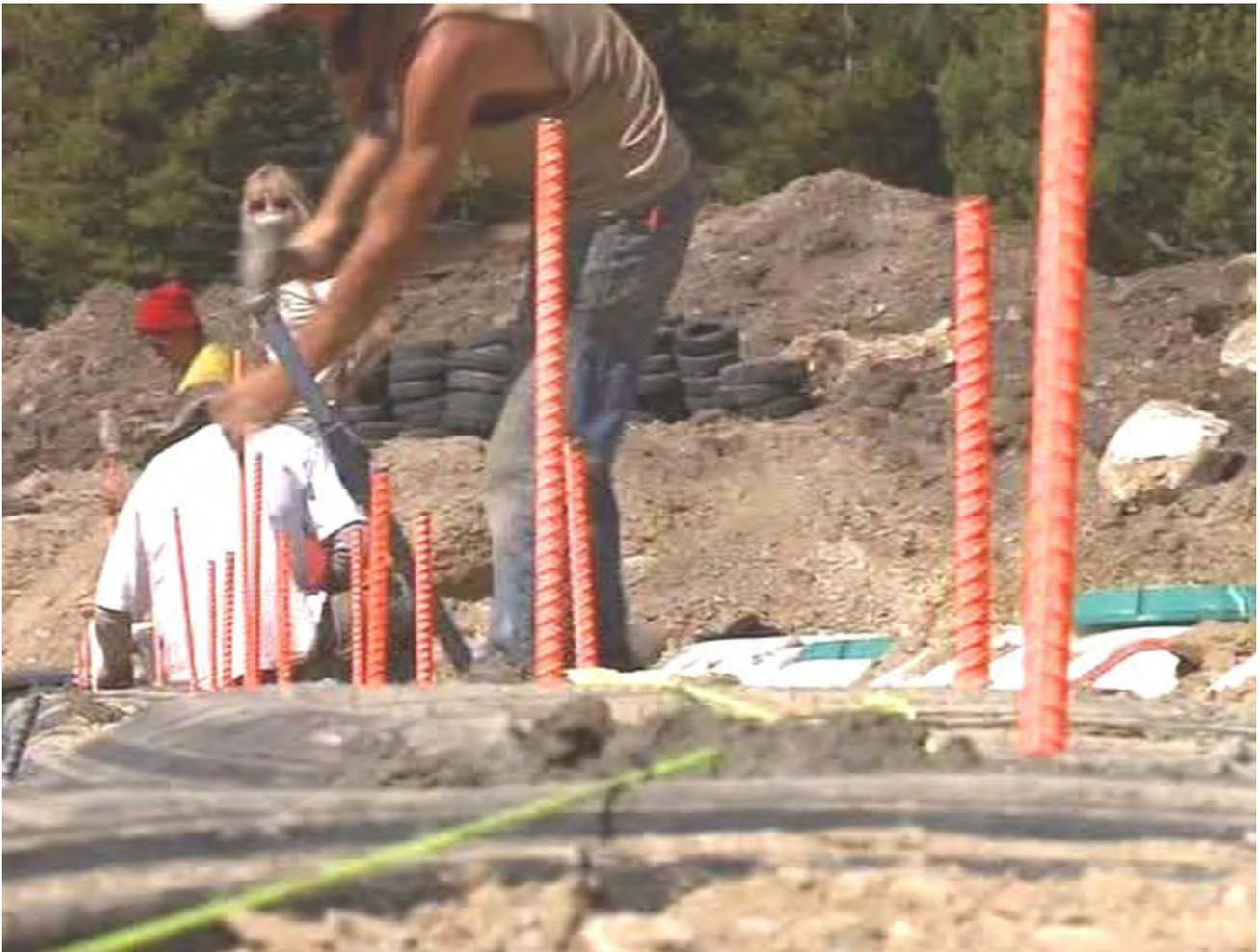
Las barras de acero llamadas "rebar" se conducen en las paredes y se colocan a la altura exacta y entonces un anillo concreto reforzado se lanza alrededor de la tapa de las paredes para dar la fuerza total a la estructura antes de que los troncos muy pesados del árbol estén colocados en él.
