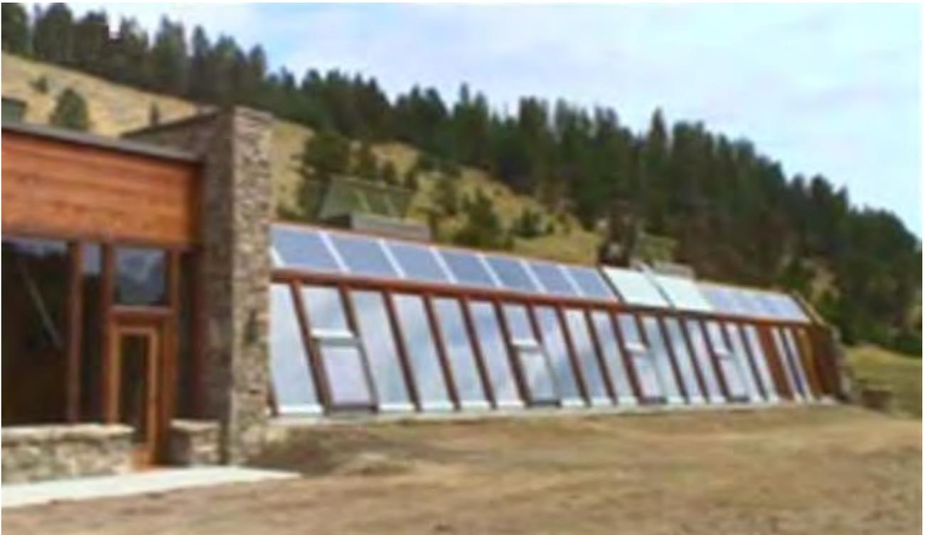
Las paredes de la propiedad son de siete pies (2,13 metros) de espesor. Esto es para permitir el uso de materiales bastante simples y más importante, para proporcionar masa térmica que mantiene el interior del edificio caliente en invierno y fresco en verano. No hay facturas significativas para la calefacción o el enfriamiento y el equipo eléctrico normal es funcionado de la energía proporcionada por los paneles solares, las baterías de un banco y un inversor de la red.
