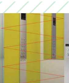
CORTINA FOTOELÉCTRICA Evita el riesgo de golpeo de las puertas permitiendo un uso más seguro del ascensor.
