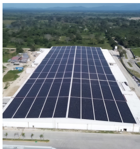
Planta Parkdale Greenfield Tipo de Cable: THHN/THWN
