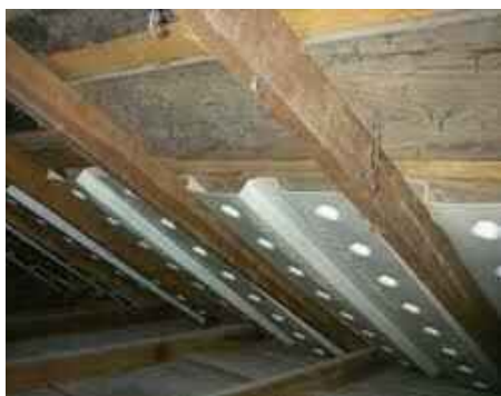
Rafter baffle vent
