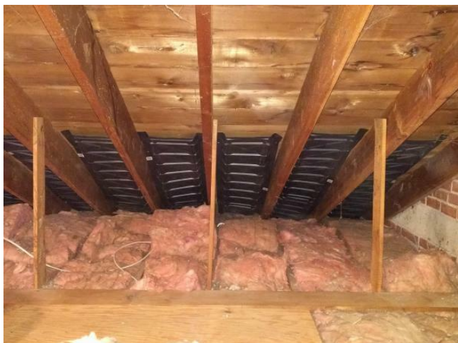
Rafter baffle vent
