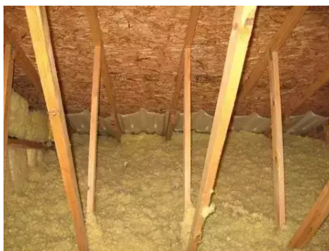
Rafter baffle vent
