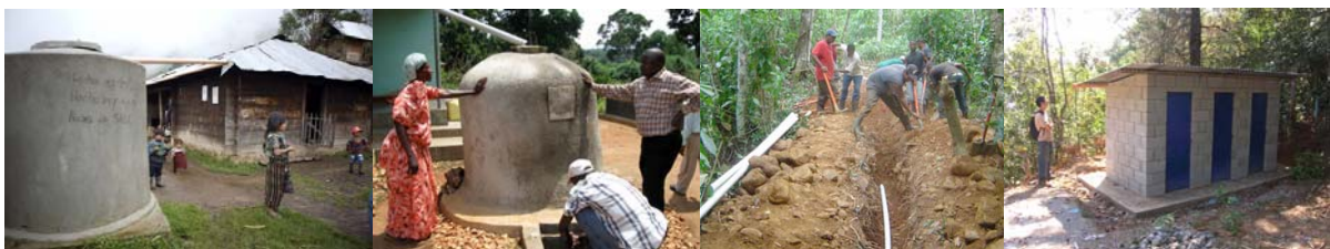
Referencias de instalaciones básicas de captación y almacenaje de agua, enterramiento de tubería y un bloque de abluciones.
