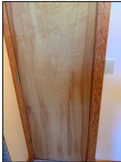
Door handle missing on sauna door
