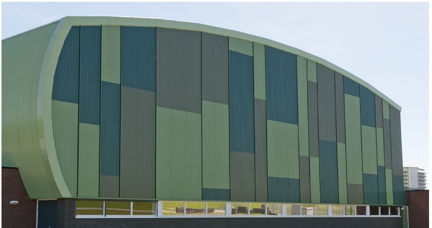
Sports center Nieuwehorne Strategie Architecten
