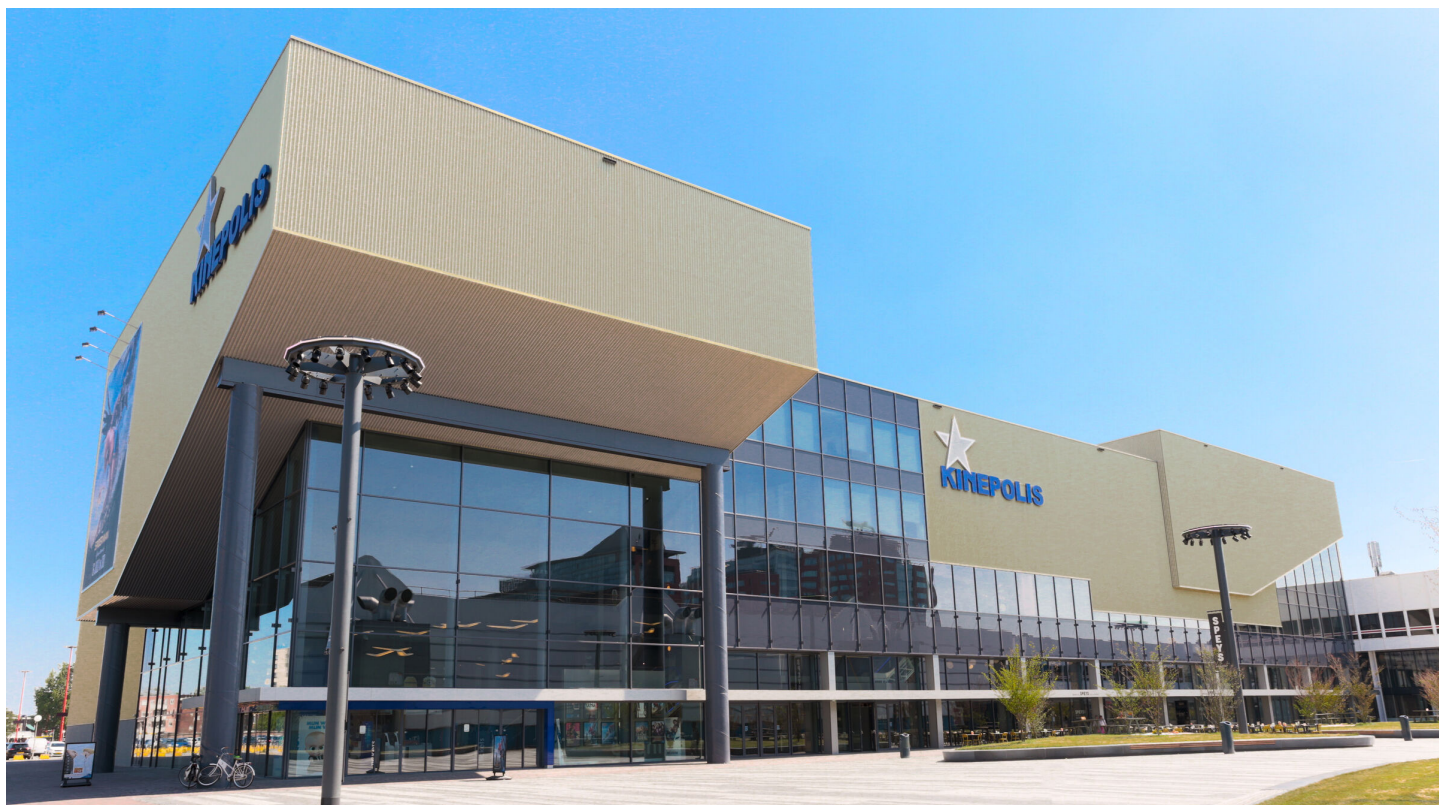
Kinepolis Utrecht - ISIS profiles Architect: Snelder Architecten
