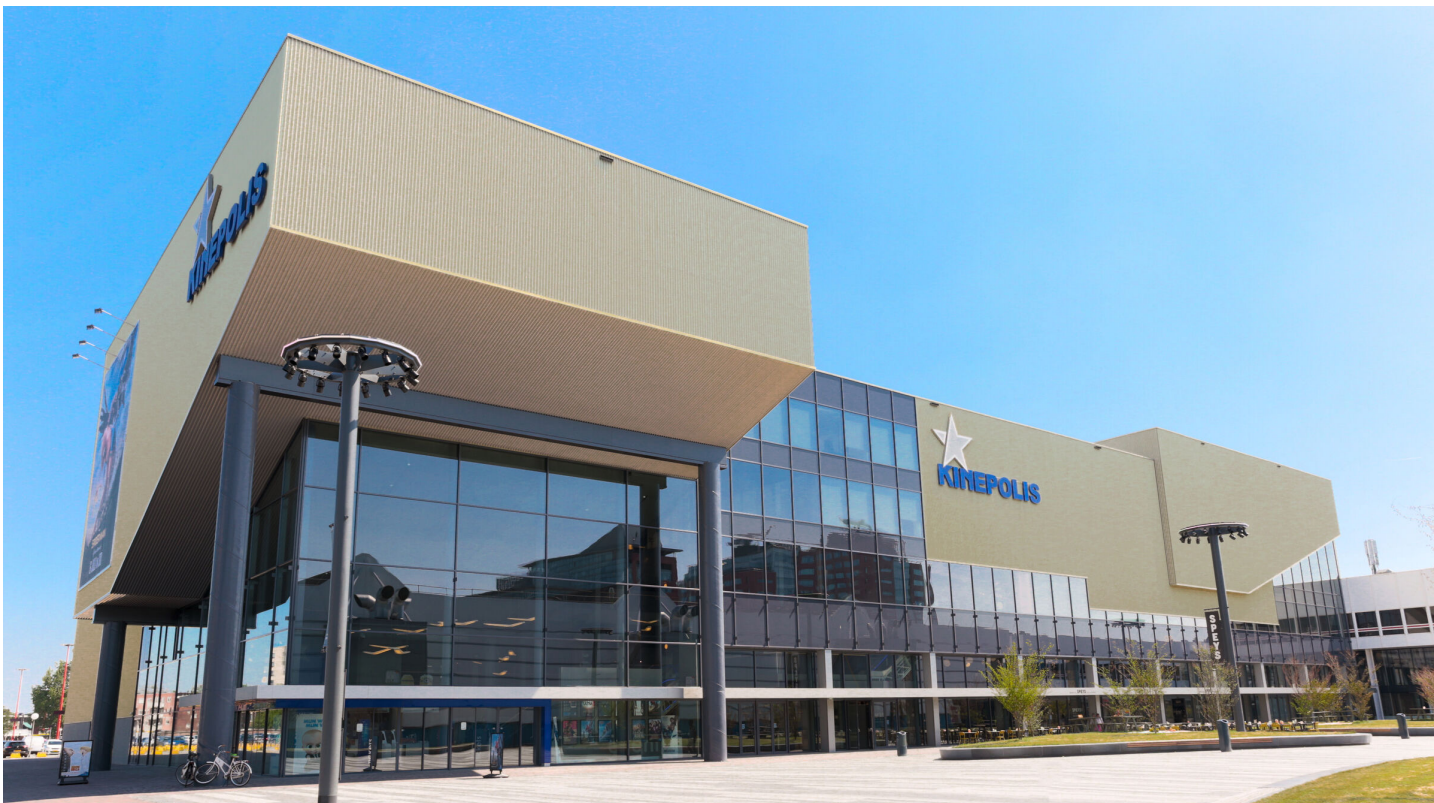
Kinepolis Utrecht - ISIS profiles Architect: Snelder Architecten
