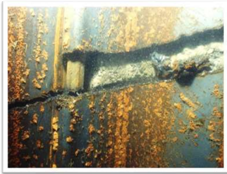
Fig. n° 49: Concrete explosive spalling (69).
