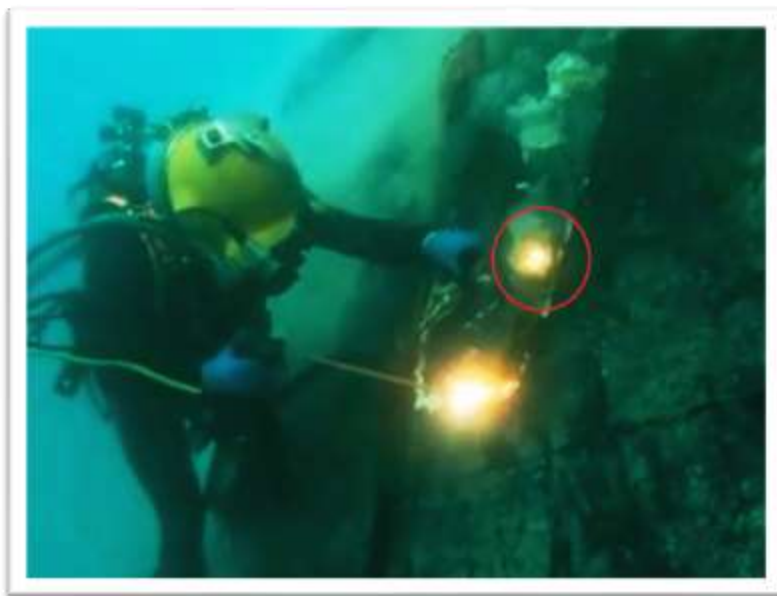
Fig. n° 8: Formation of flammable gases (14).
