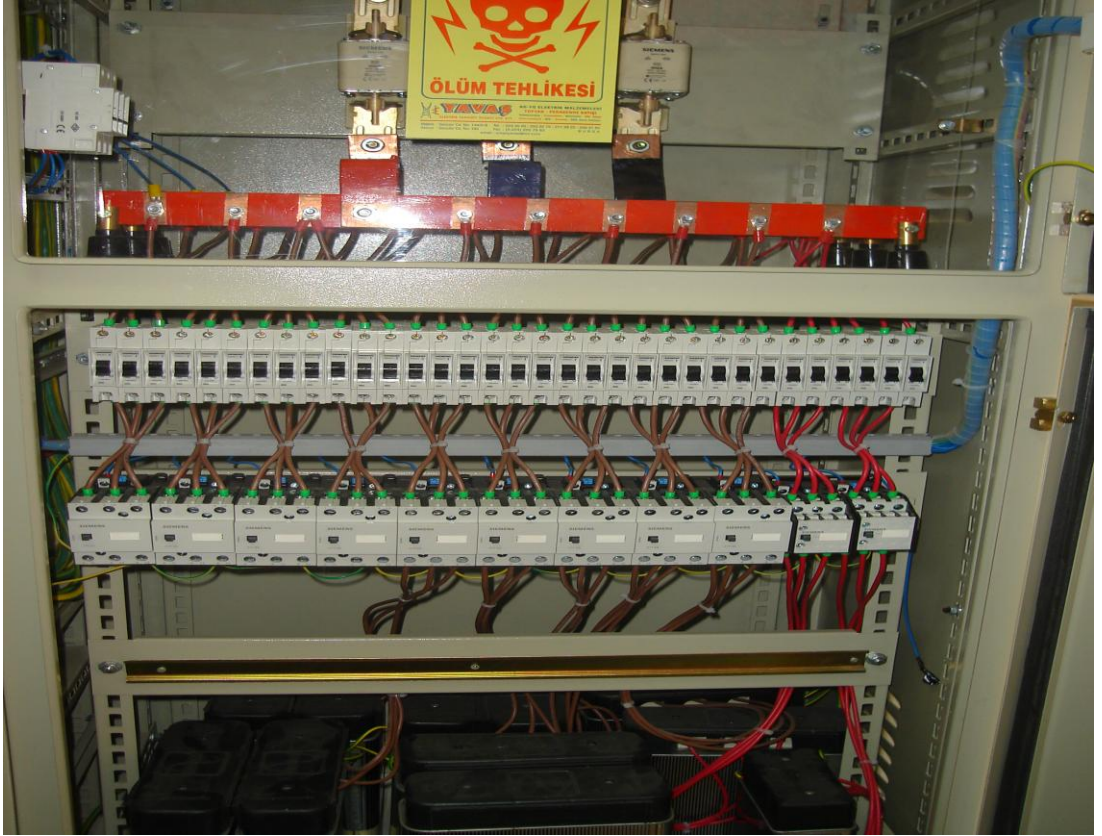
Resim 3.9: Kompanzasyon panosunda kullanılan kontaktörler
