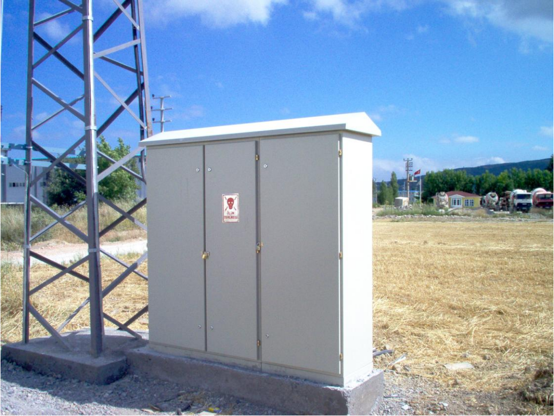
Resim 2.7: AG dağıtım pano harici montajı ve platform
