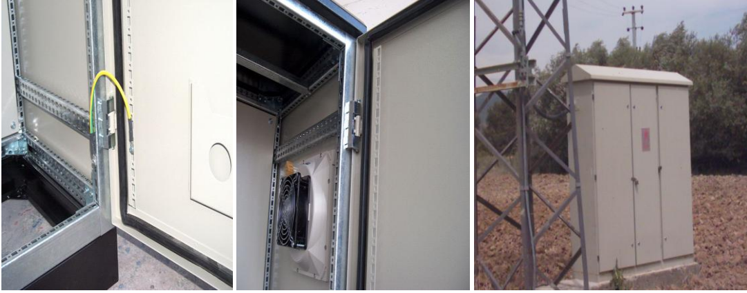
Resim 3.1: Kompanzasyon pano kapak topraklaması, pano aspiratörü, panonun eğimli üstü
