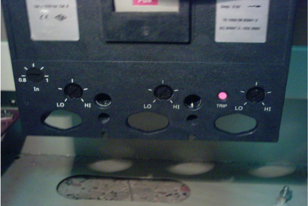
Resim 2.9: Kompakt şalter ayar bölümü ve trip butonu
