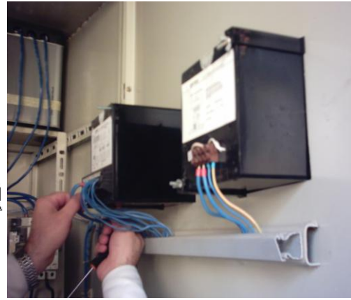
Şekil 4.6: Kompanzasyon panosu tek hat şeması Resim 4.8: Regler ve cos \phi metre montajı
