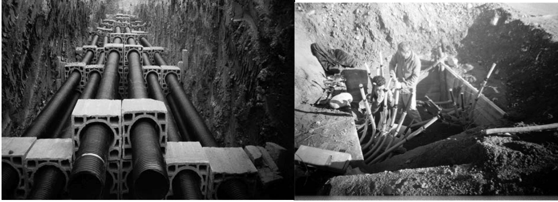
Resim 2.1: Yer altı enerji hattının çekilmesine ilişkin çalışmalar.
