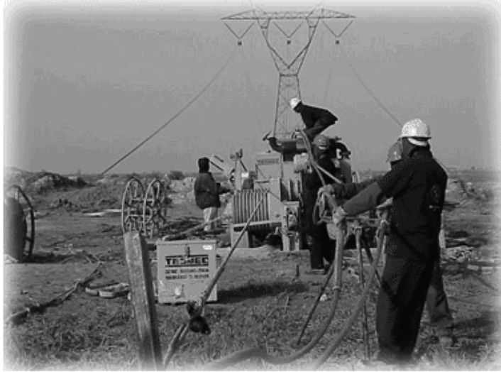
Resim 2.2: Yüksek gerilim havai enerji hattında iletken çekilmesine ilişkin çalışmalar.
