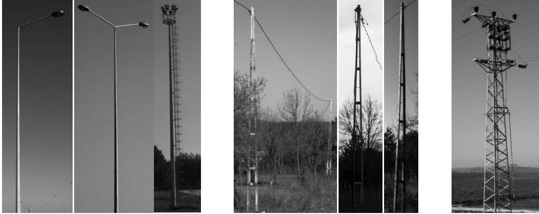
Resim 5.1: a) Boru direkler
