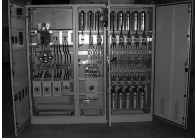
Resim 6.6: Alçak gerilimde kullanılan kompanzasyon panosu.
