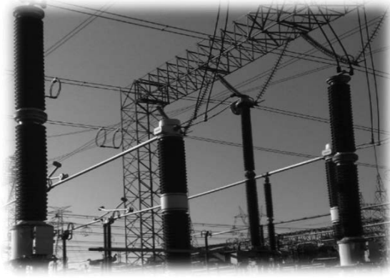
Resim 3.5: Akım transformatörü.
