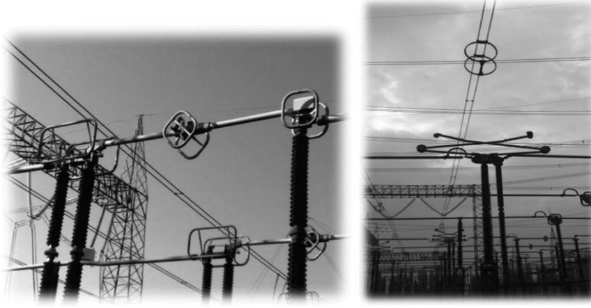
Resim 3.11 a) Yatay pantograf tipi ayırıcı.
