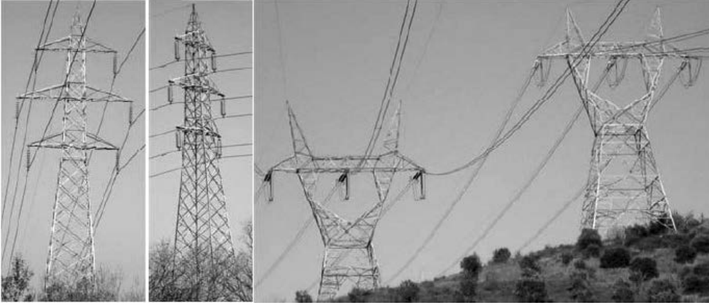
Resim 5.2: Putrel/pilon/çatal direkler
