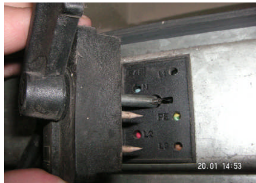
Resim 4.18: Bus-bar anahtarının yuvaya takılması
