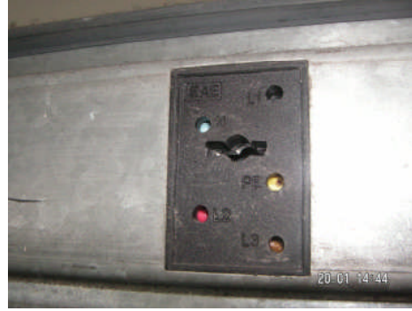
Resim 4.16: Bus-bar anahtarının takıldığı yuva
