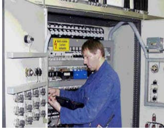
Resim 5.9: Dağıtım panosunda bakım ve onarım
