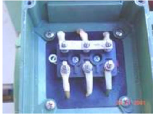
Resim 3.11: Üç fazlı AC motor klemens kutusu (a), Yıldız bağlantı şekli (b)
