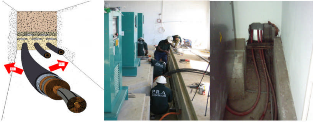
Resim 5.7: Beton kanallarda kablo bakımı
