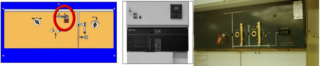
Şekil 2.14: Hücre üzerindeki asma kilidin kapatılması
