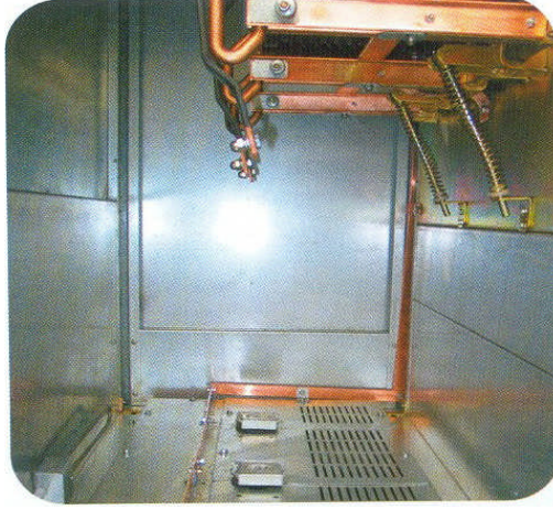
Resim 1.21: H cre i i aydınlatma
