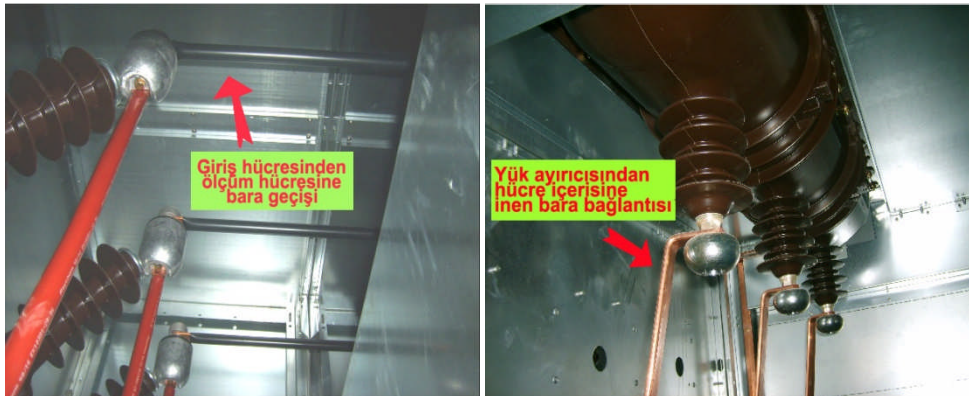
Resim 2.3: Ölçüm hücresine bara geçişleri
