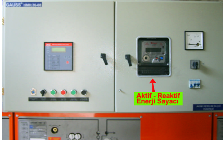
Resim 1.8: Kombi sayacın ölçü hücresi üzerindeki konumu
