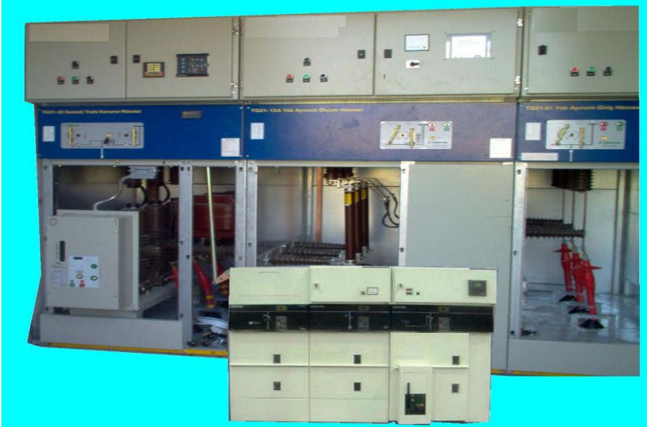
Resim 1.3: Yan yana getirilmiş giriş-ölçü-çıkış modüler hücreleri
