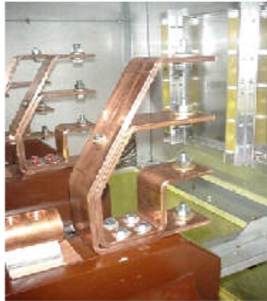
Resim 2.4: Bükülmüş baraların montajlı hâli
