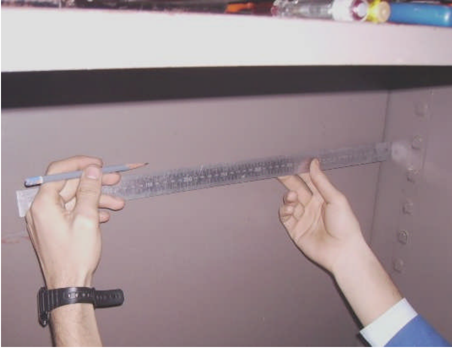
Resim 1.3: Pano üzerinden bara ölçülerinin belirlenmesi
