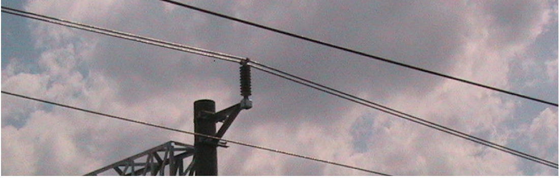
Resim 1.7: Fider teli montajı
