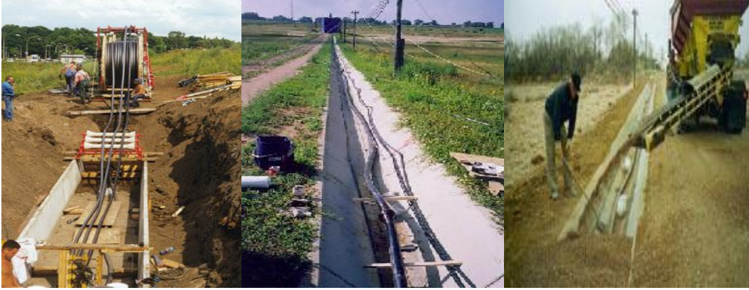
Resim 2.15: Kabloların beton kanallara dőşenmesi ve kanalın kapatılması
