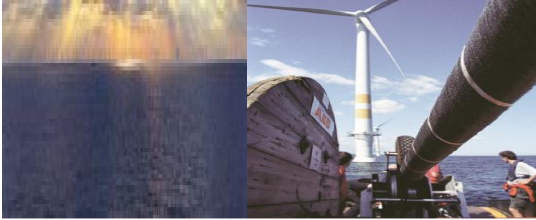
Resim 2.19: Denizde bulunan rüzgar santrali ve kablo çekimi
