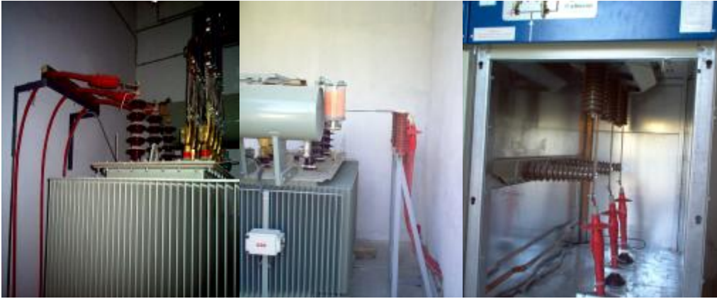
Resim 4.11: Dahili başlıklı kabloların trafo ve modüler hücrelere bağlantısı
