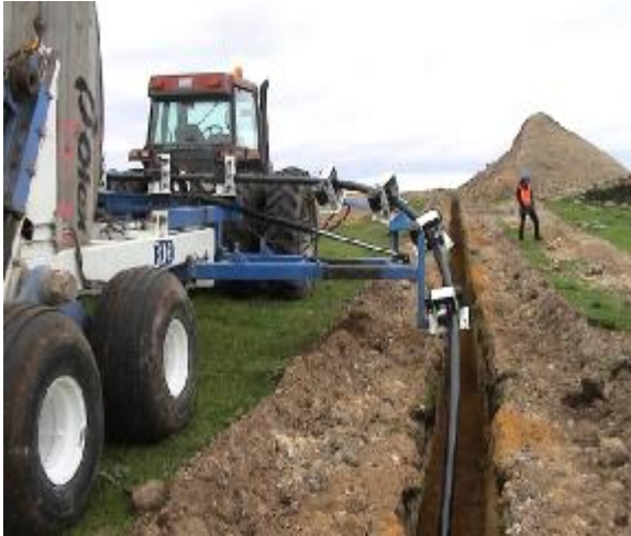
Resim 2.8: Kablonun serilmeden dönebilmesi
