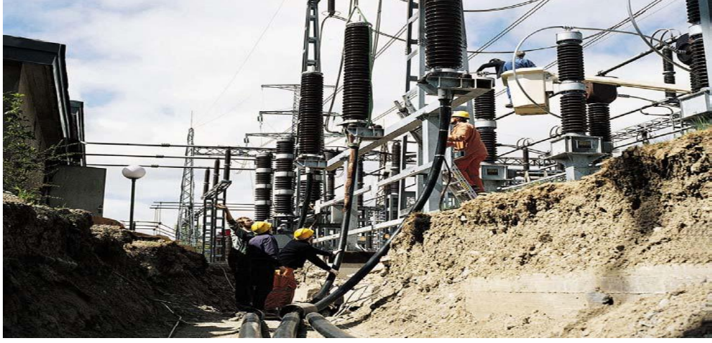
Resim 4.8: Şalt sahasında porselen başlığa yer altı kablo bağlantısı(240 KV)
