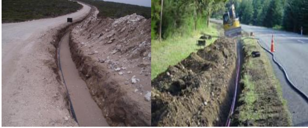
Resim 2.11: Kanala kum döşenmesi ve kablounun yerleştirilmesi
