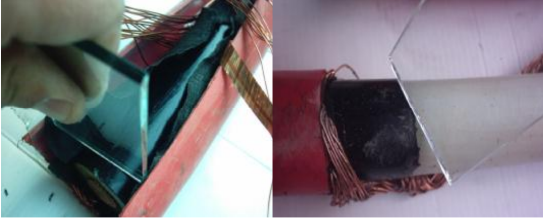
Resim 3.11: YE3SV kablunun yarı iletken tabakasının cam parça ile soyulması
