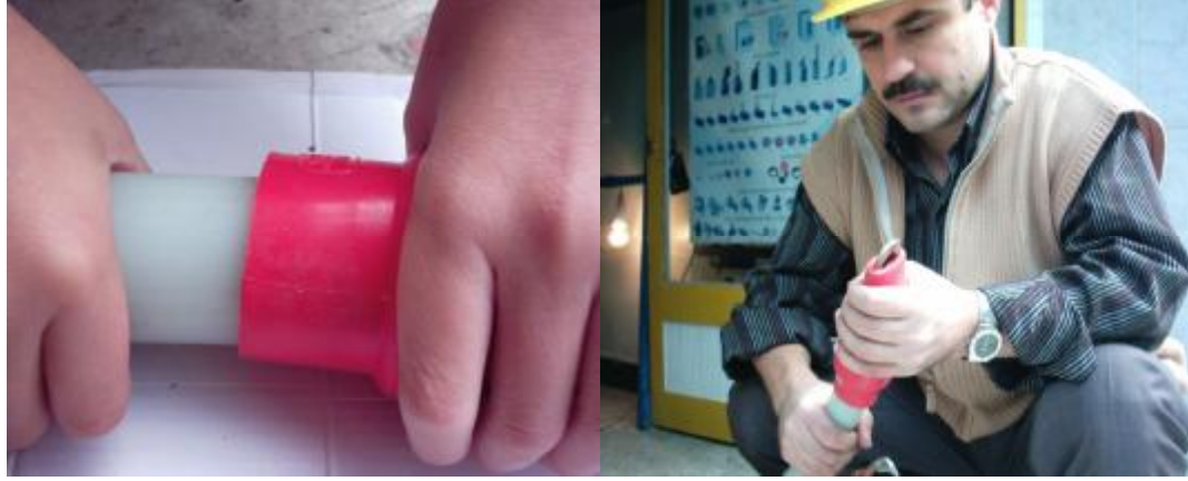
Resim 3.14: YE3SV kabloya silikon başlığın takılması
