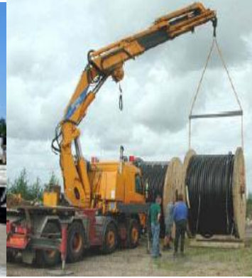
Resim 2.2: Kablo makarası ve indirilmesi
