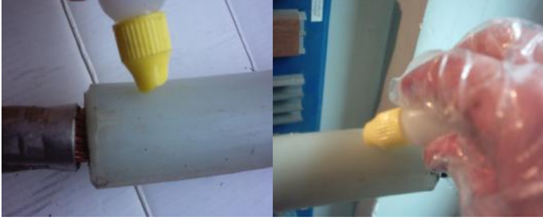
Resim 3.13: YE3SV kablo yalıtkanı üzerine başlığı takmadan önce silikon yağının sürülmesi
