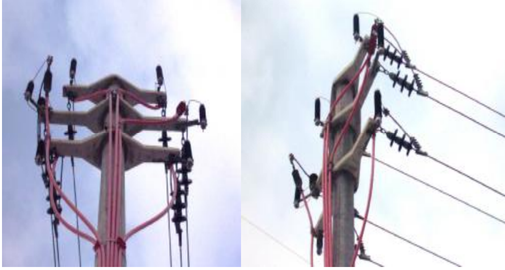
Resim 4.10: Başlıklı kabloların havai hatlara bağlantısı(Parafudur korumalı)
