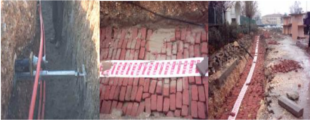
Resim 2.16: Kabloların kanala dőşenmesi ve tuęlaların yerleřtirilmesi
