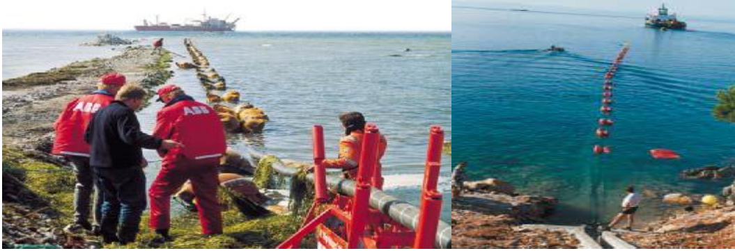
Resim 2.22: Kablonun denizden çekilmesi
