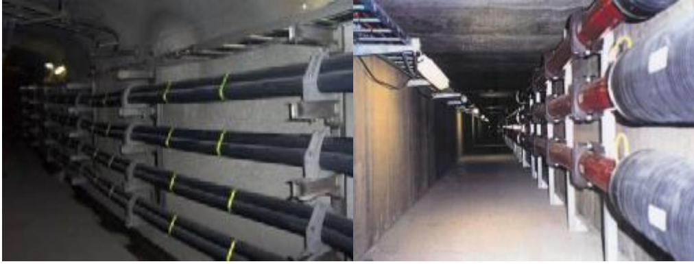
Resim 2.26: Kablonun kroşelerle ve kablo merdiveni ile duvardan döşenmesi
