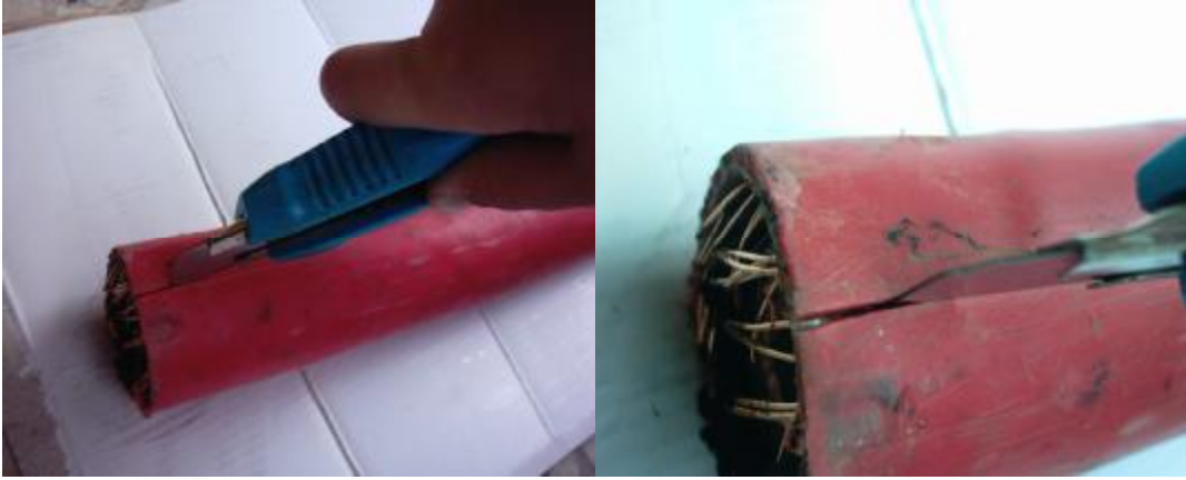
Resim 3.8: YE3SV kablunun dış kılıfının kesilmesi
