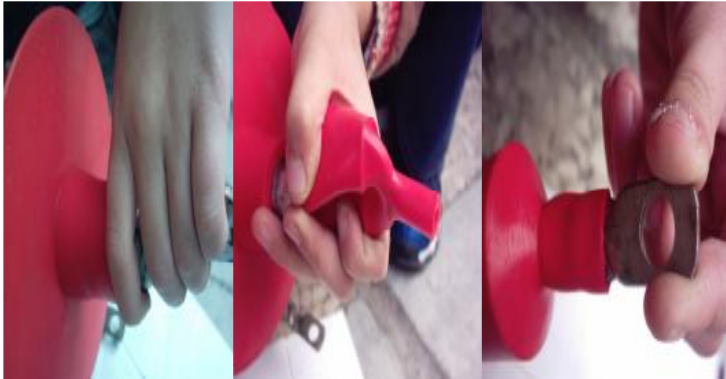
Resim 3.15: YE3SV kabloya silikon izolatör (yaprak) ve uç koruyucu şapka takılması
