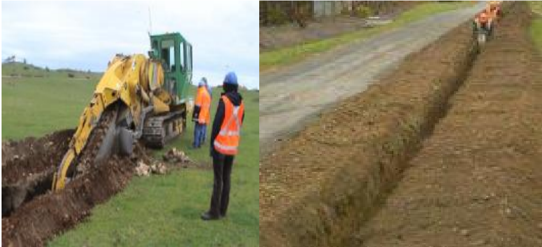
Resim 2.10: Toprak zeminde kablo kanalı açma
