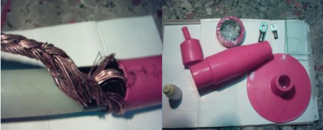
Resim 3.12: YE3SV kablunun bakır tellerinin burulması ve kablo başlığı montaj seti
