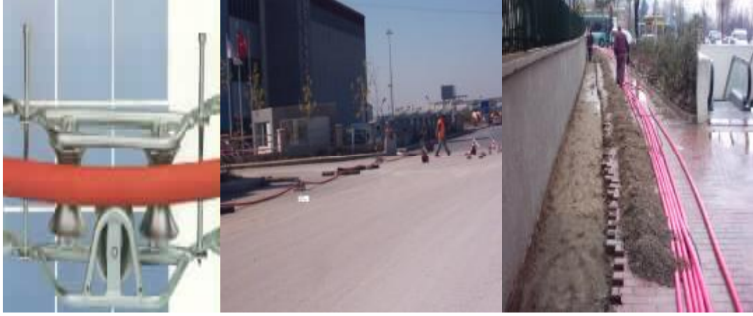
Resim 2.6: Kablo taşıyıcı ve kablo serilmesi
