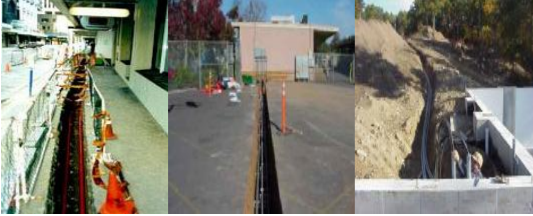
Resim 2.14: Kablonun deęiřik tipte kanallara dőşenmesi
