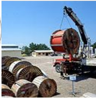
Resim 2.2: Kablo makarası ve indirilmesi
