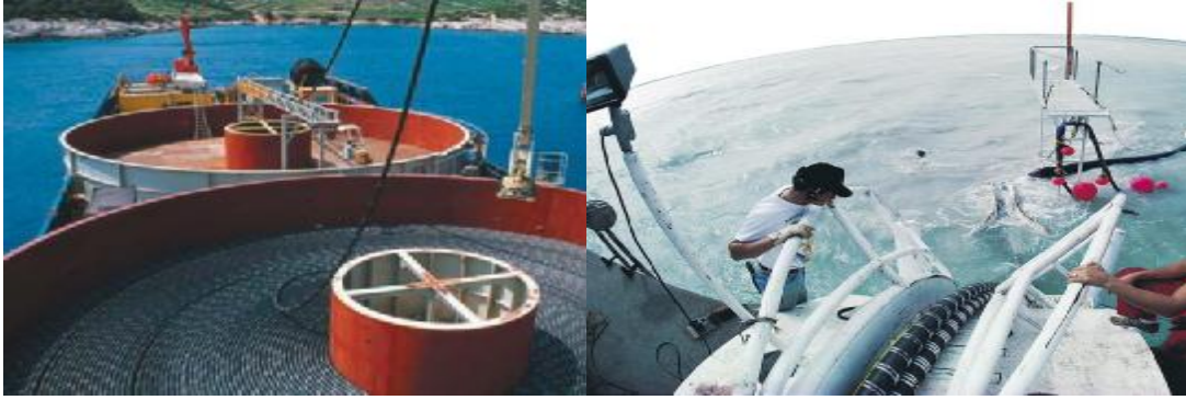
Resim 2.21 : Kablonun döşeme aracından denize indirilmesi
