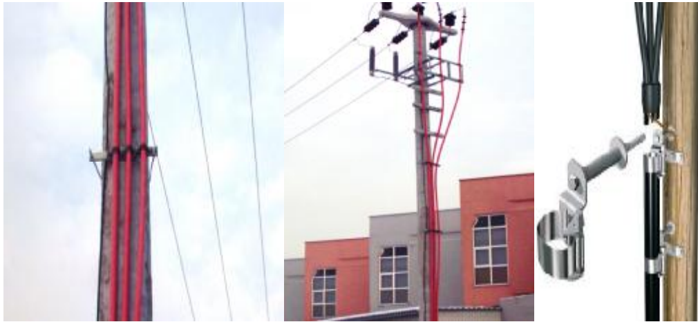
Resim 4.7: Yer altı kablolarının direğe sabitlenmesi
