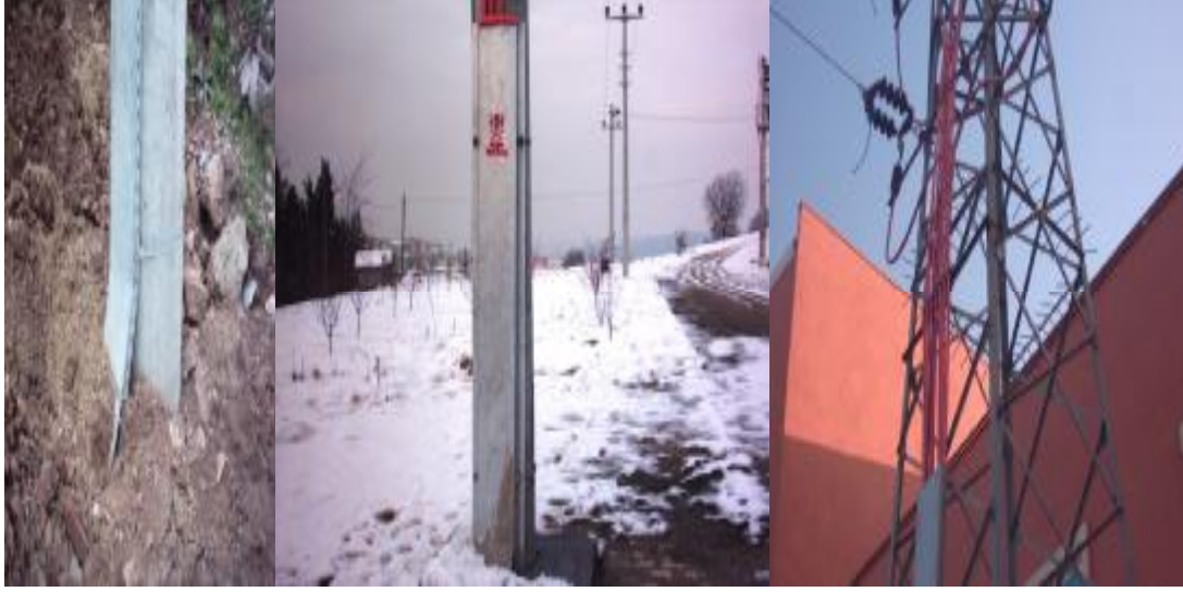
Resim 4.5: Direkte bağlantı yapılan kabloların saç kanal ile korunması
