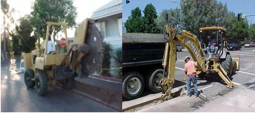
Resim 2.9: Sert zeminde kablo kanalı açma
