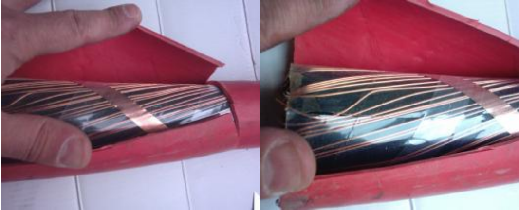
Resim 3.9: YE3SV kablunun kesilen dış kılıfının ve koruma bandının çıkarılması
