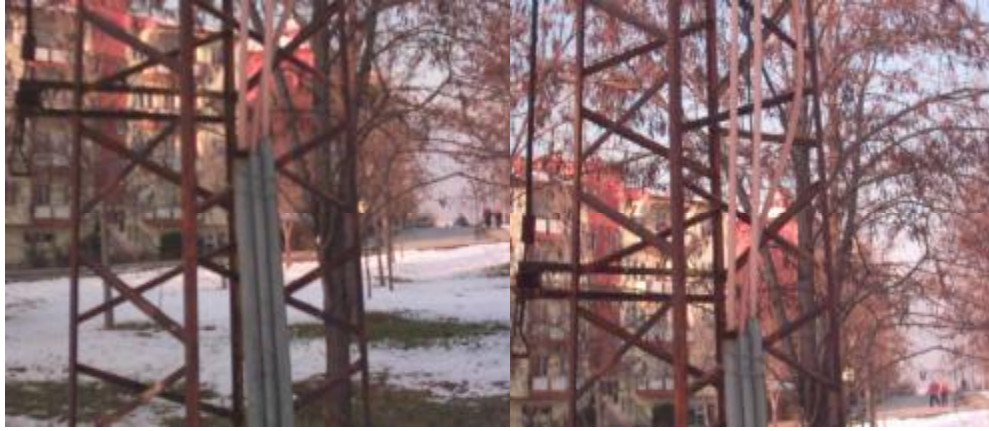
Resim 4.6: Kabloların ayrı ayrı boru içinden geçirilerek korunması
