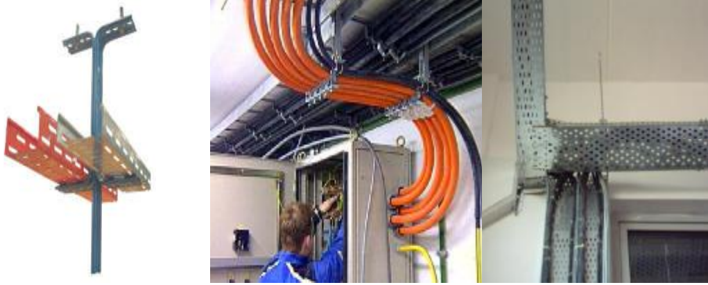
Resim 2.27: Tavan altına kabloların köprü-putrel ve delikli sac kanaldan döşenmesi
