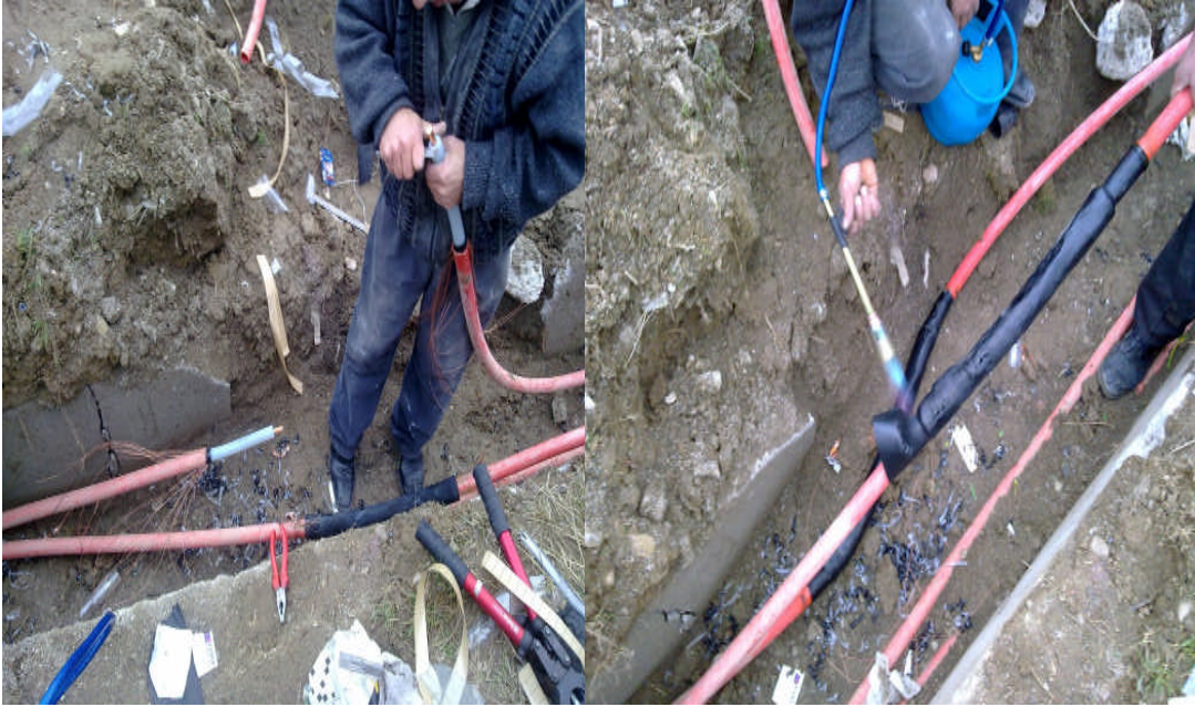
Resim 1.51: Yer altı kablo ek yapılması
