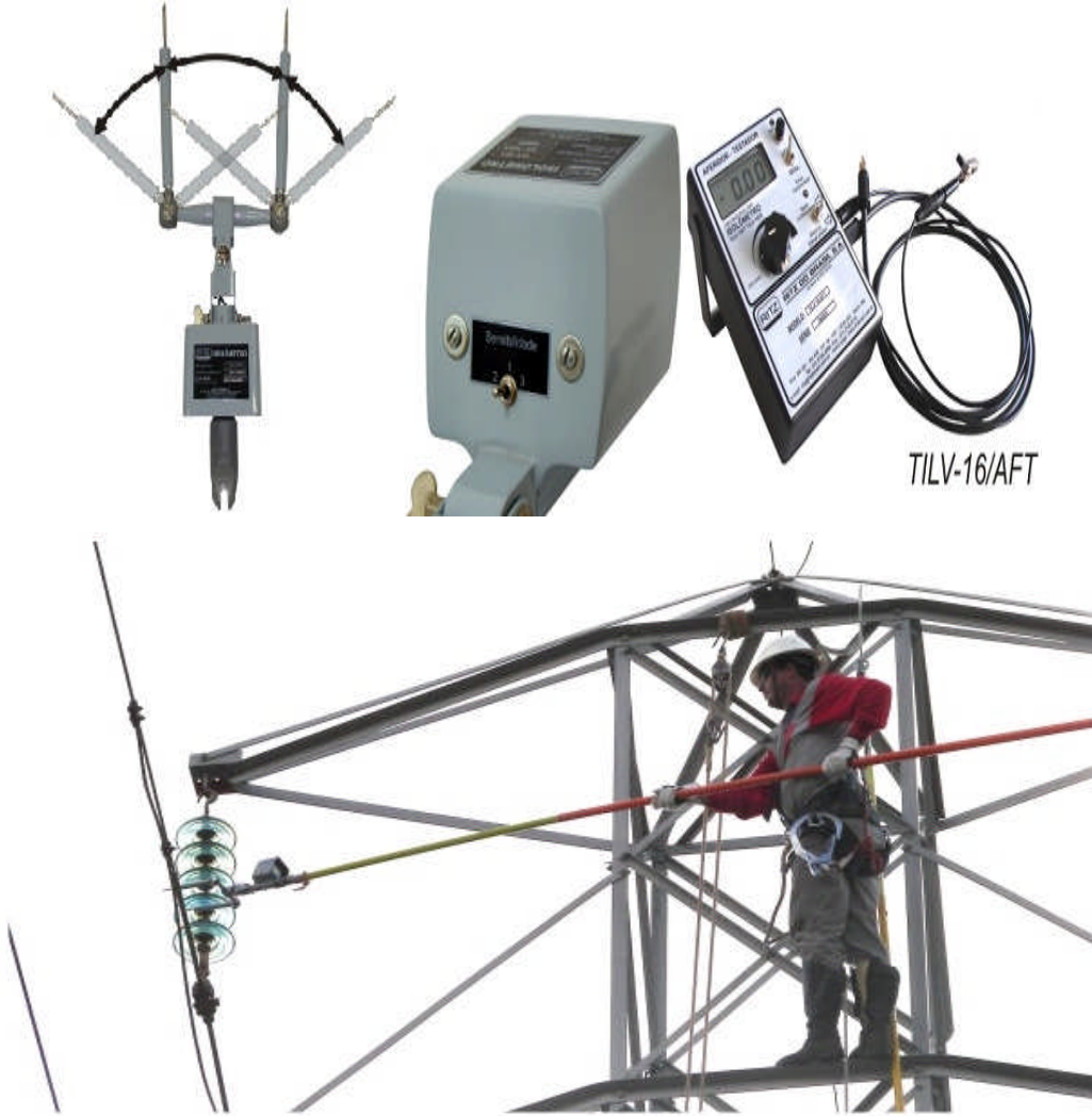
Resim 1.37: İzolometro cihazı ile hatalı, arızalı izolatörlerin tespit edilmesi
