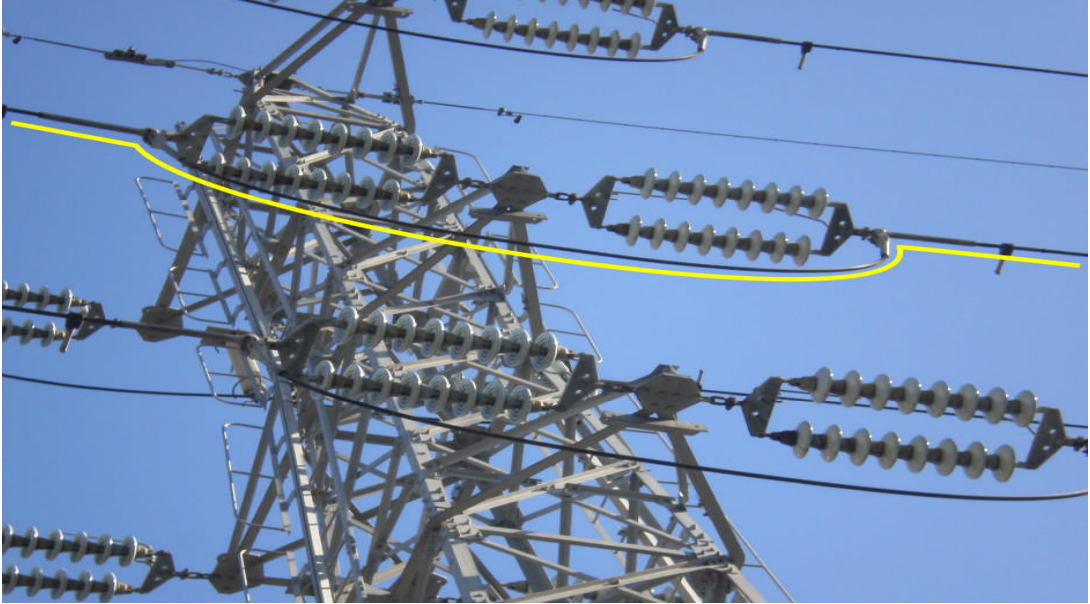
Resim 1.41: Camper (gevşek irtibat) kontrolü
