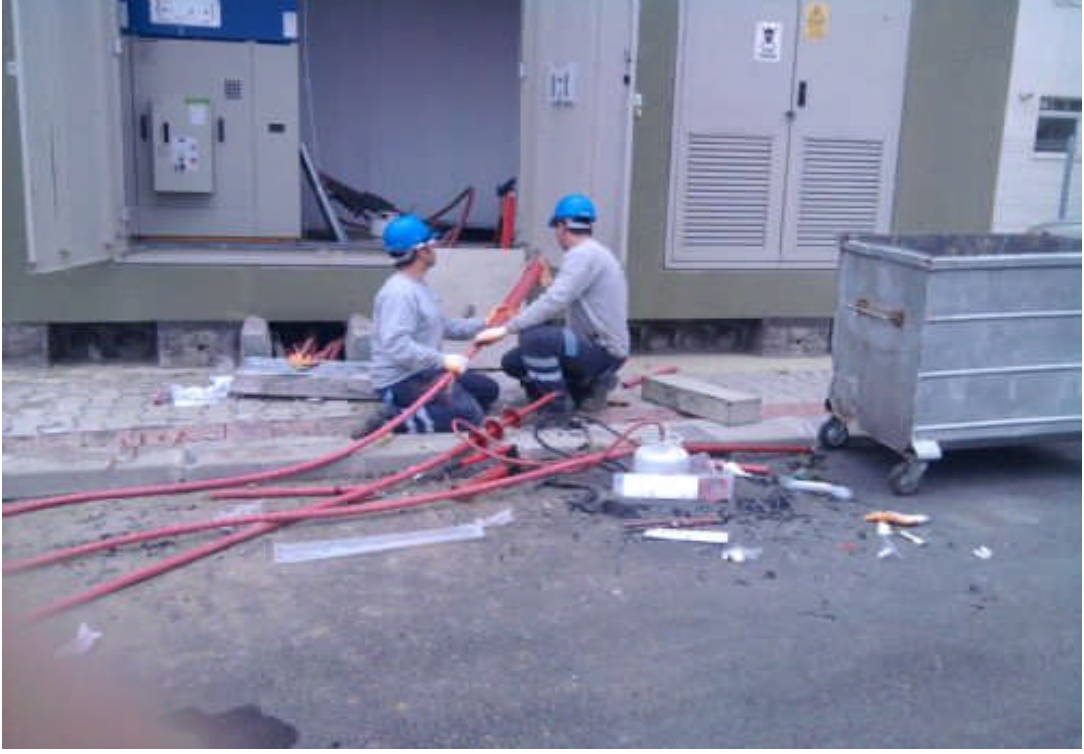
Resim 1.52c: Kablo başlığı takılması
