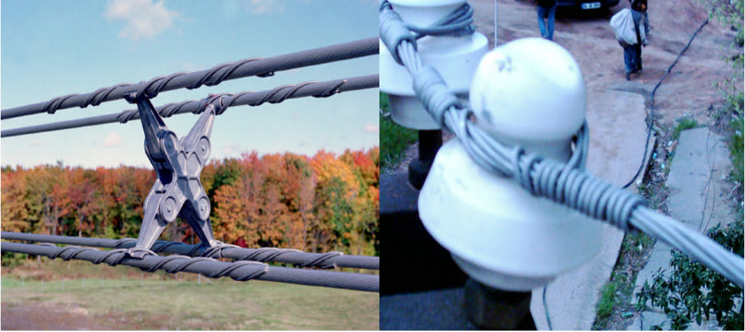
Resim 1.46: Spacer (ara bağlantı) ve izolatör bağlantısı
