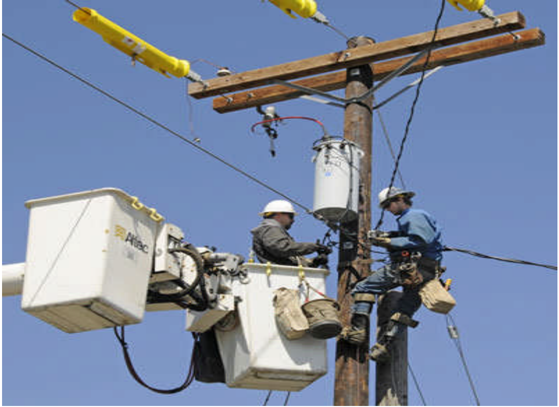
Resim 1.29: Ağaç direkte bakım onarım yapılması
