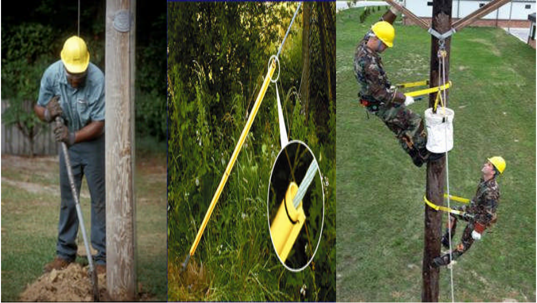
Resim 1.30: Ağaç direk temeli, lente ve direk bakımı yapılması
