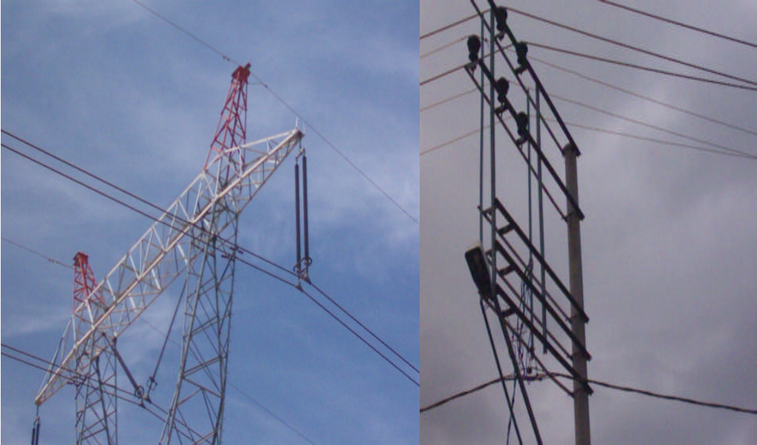
Resim 1.33: Demir travers ve demir konsollar
