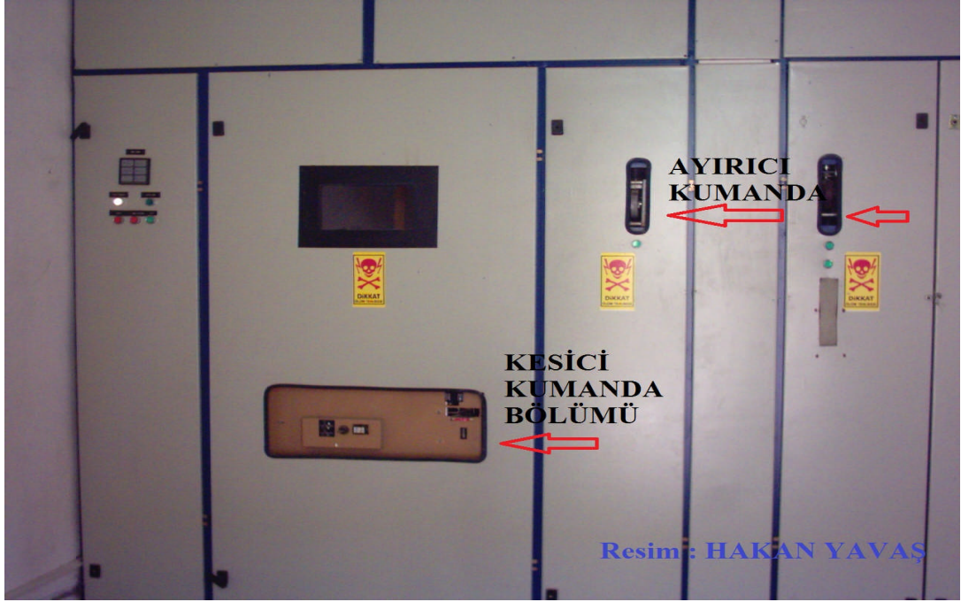
Resim 1.15: Eski tip açık sistem hücrelerde kesici ve ayırıcı kumandası
