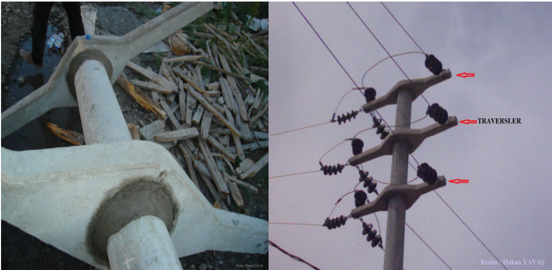
Resim 1.31: Beton traversler
