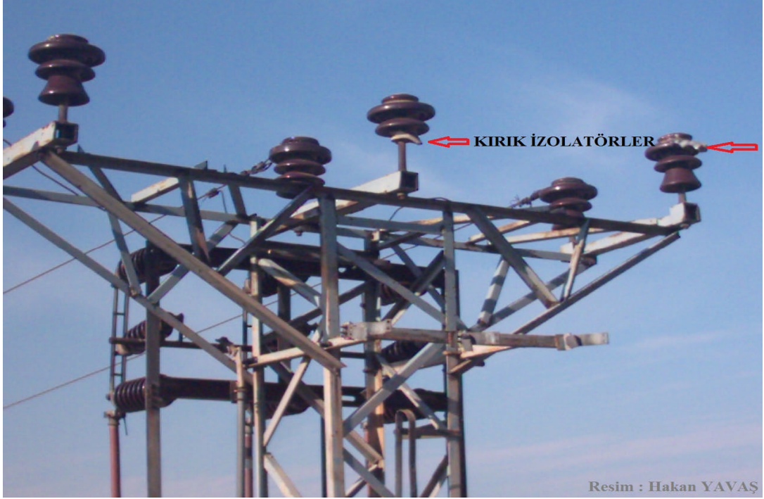
Resim 1.35: Direkte bulunan kırık izolatörler
