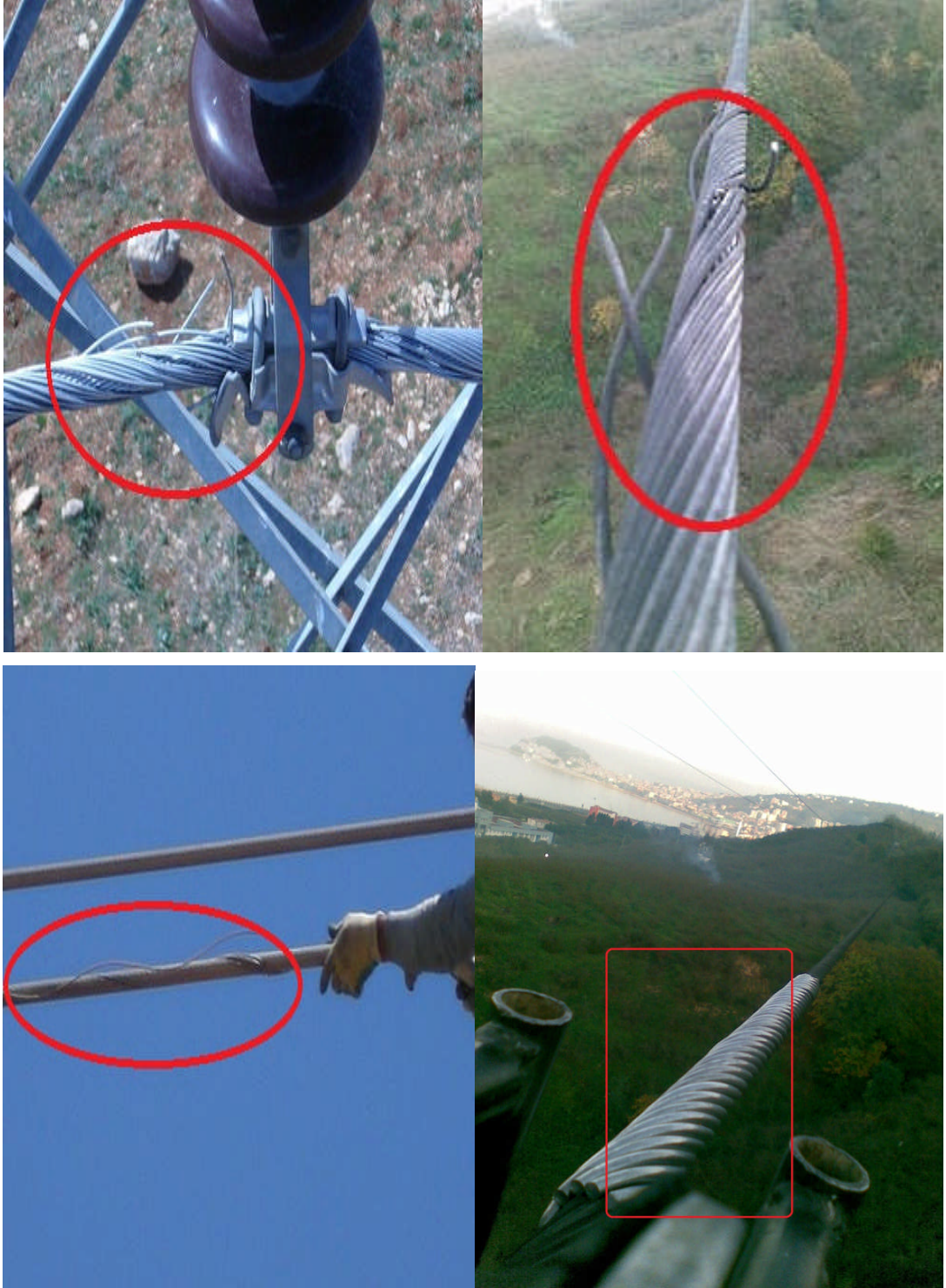
Resim 1.47: Havai hat iletkeninde oluşmuş kopmalar ve kopmaların giderilmesi
