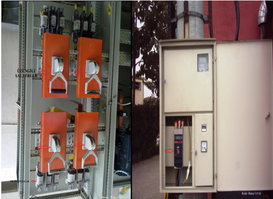
Resim 1.8: Üzengili ve ölçüm panosunda termik manyetik şalter
