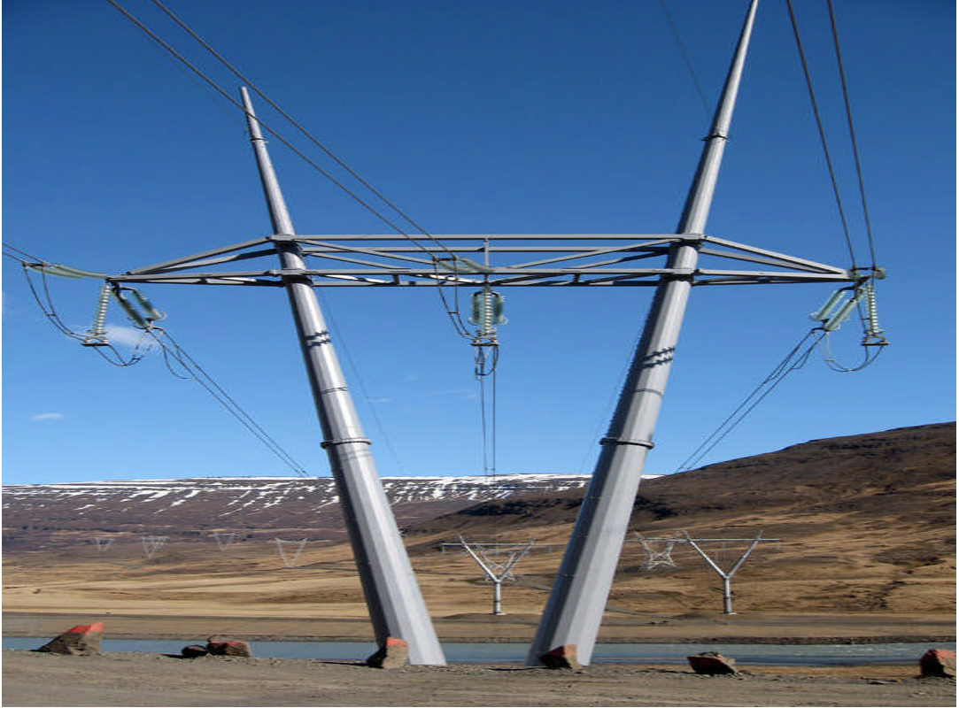
Resim 1.20: Alüminyum-çelik-galvaniz YG direği
