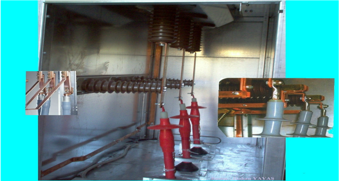
Resim 2.11: OG modüler hücre iç yapısı
