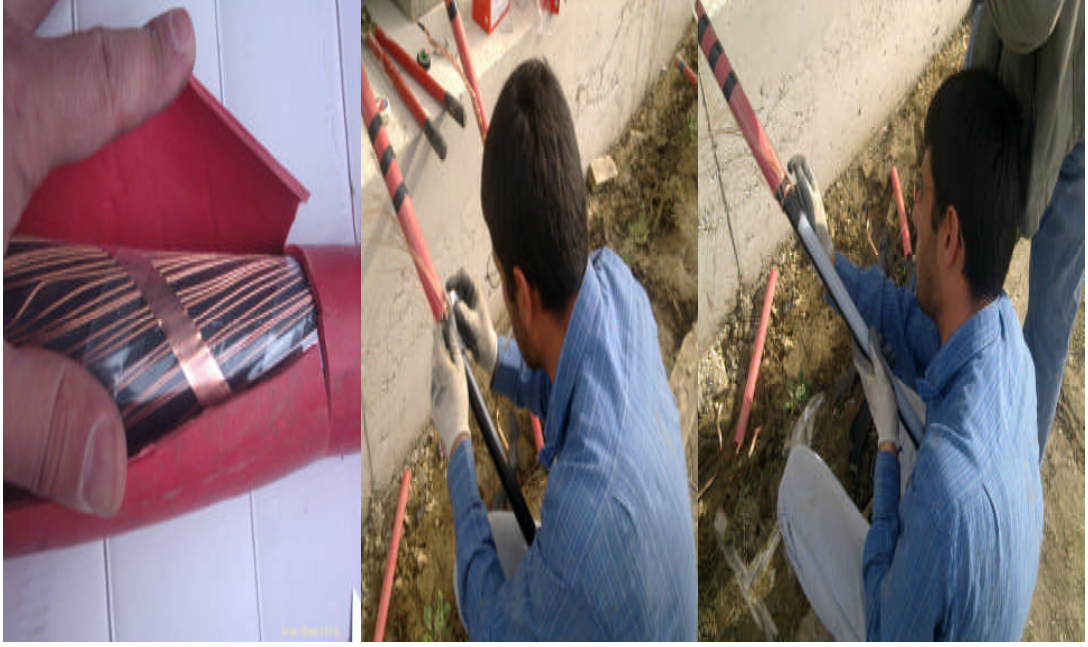
Resim 1.52a: Kablo başlığı takılması
