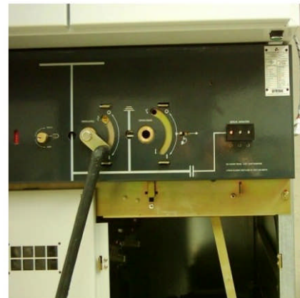
Resim 1.12: OG modüler hücre yük ayırıcısı kumandası
