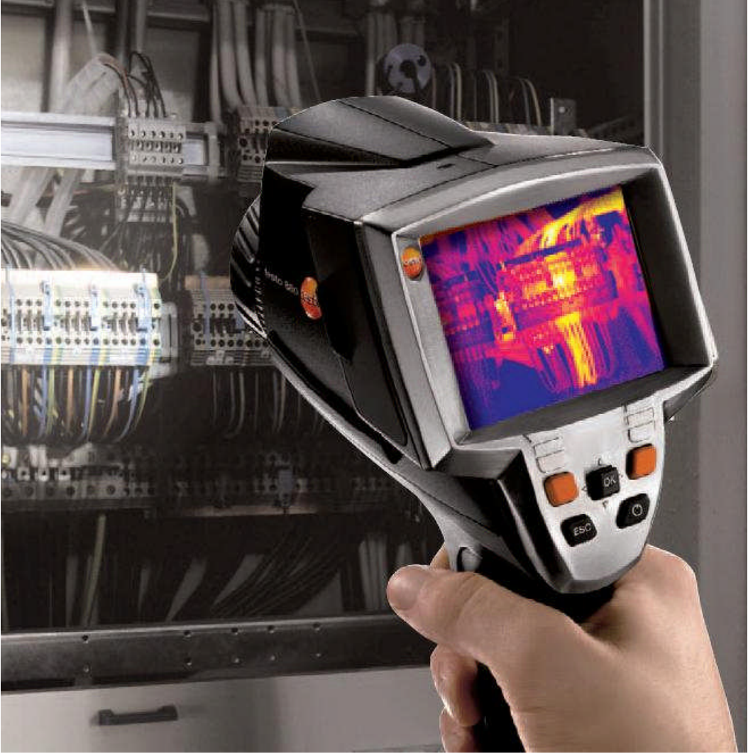
Resim 2.9: Termal kamera ile pano bağlantıları kontrolü
