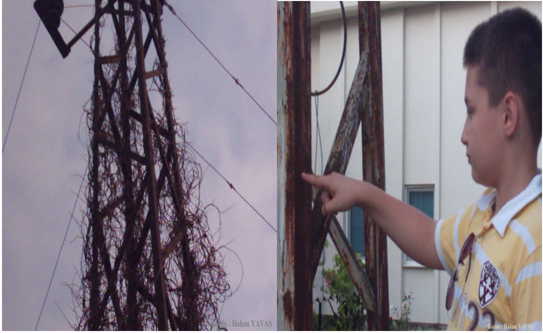
Resim 1.21: Bakımsız demir direkler (sarmaşık kaplanmış ve paslanmış direkler)
