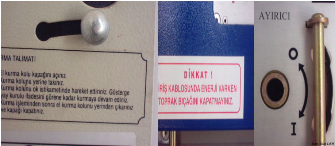
Resim 1.11: OG modüler hücrede bulunan ayırıcı çalıştırma talimatı
