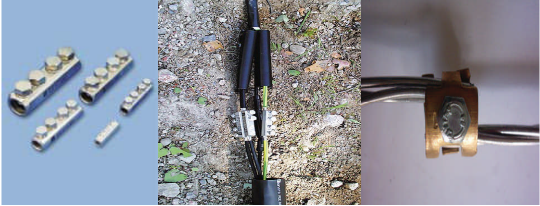
Resim 1.53: Havai hat iletken eki yapılması
