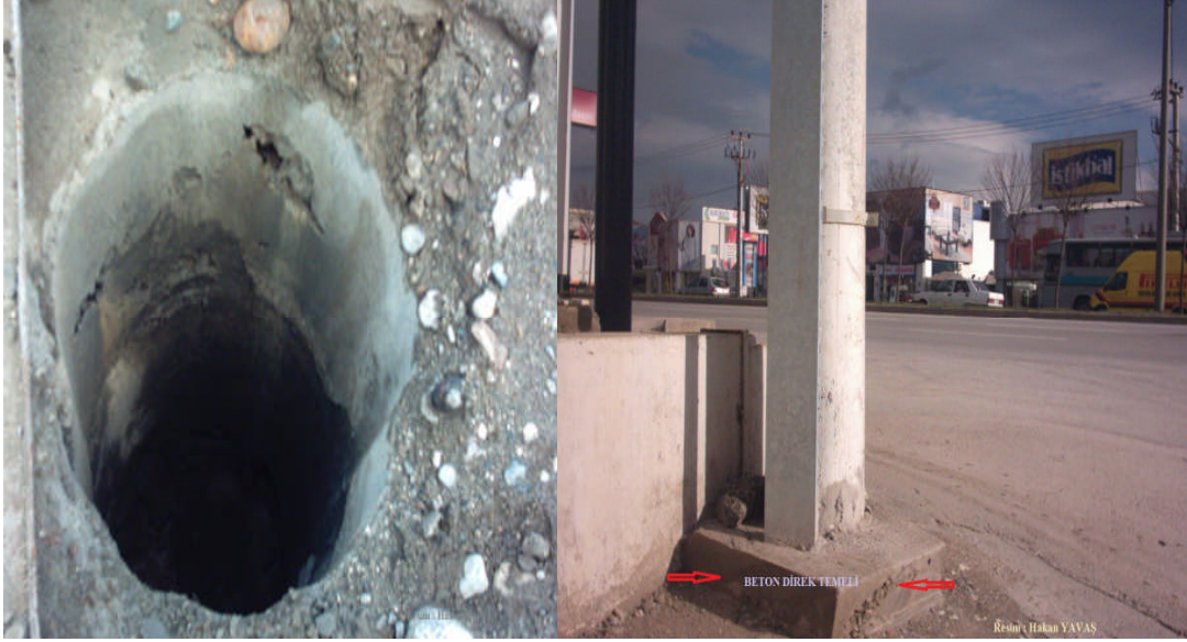
Resim 1.18: Beton direk temeli
