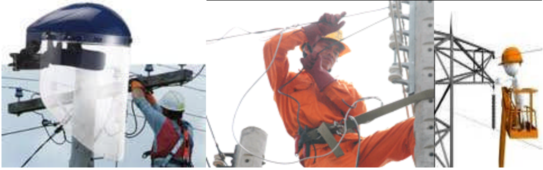
Resim 1.3: Baret ve emniyet kemeri kullanılması
