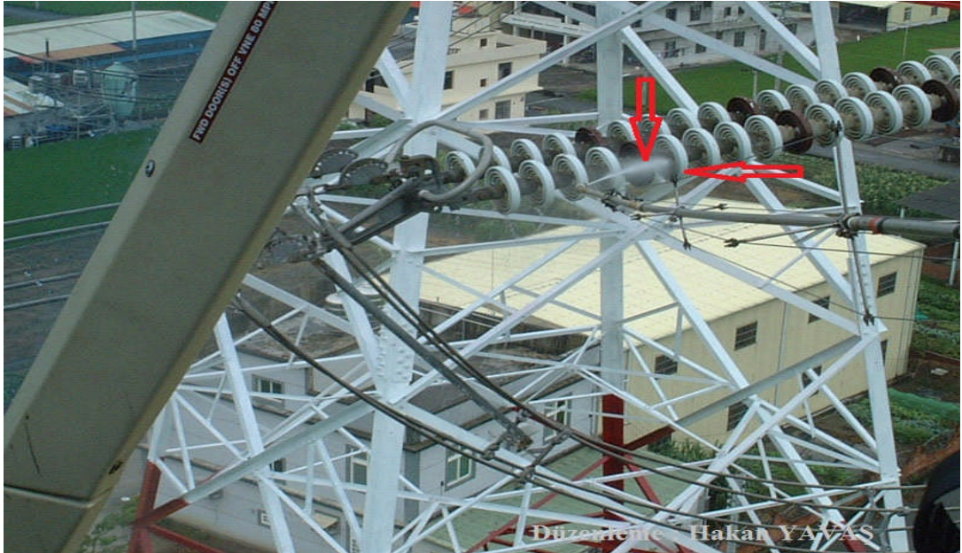
Resim 1.36: İzolatörlerin üzerindeki birikintilerin ilaı su ile temizlenmesi
