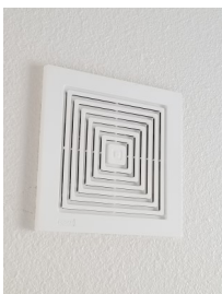
CEILING VENT FAN
